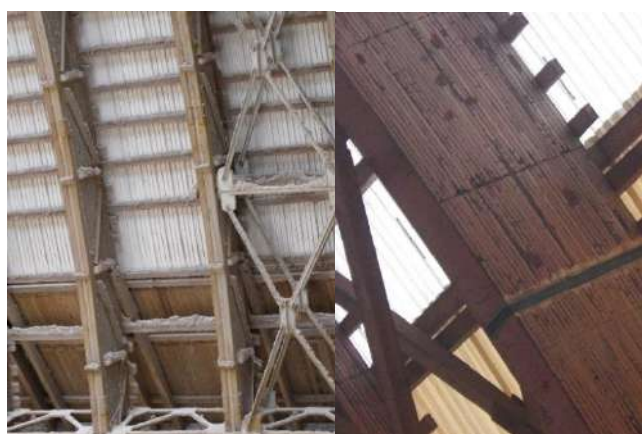
Рисунок 1 – Способы усиления деревянных арочных конструкций:
