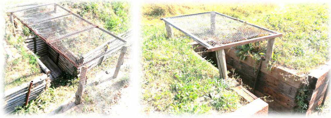
Рисунок 5 – Противодронный козырек для защиты личного состава на позиции отделения
