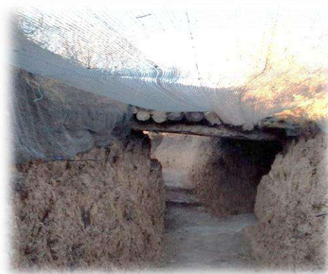
Рисунок 4 – Оборудование хода сообщения противодронной сеткой
