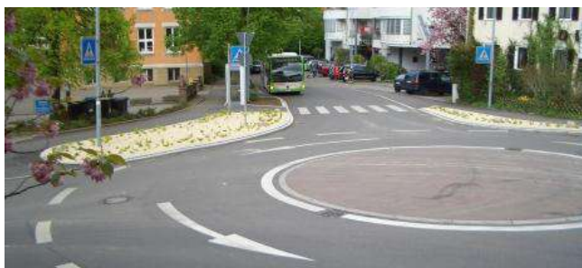
Рисунок 3 – Кольцевое пересечение с малым радиусом центрального островка (Minikreisel) в Германии
