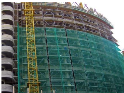
Рисунок 1 – Строительство зданий в сейсмической зоне
