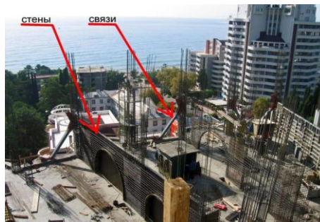
Рисунок 2 – Установка металлических связей при строительстве зданий в сейсмических зонах
