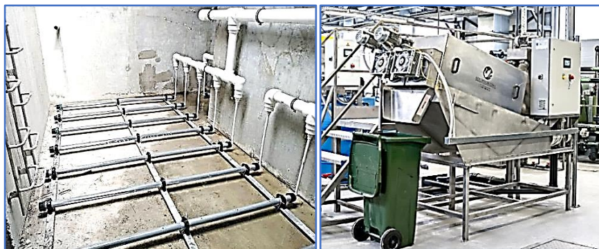
Рисунок 2 – Железобетонный биоблок с установленными аэрационными элементами (слева) и шнековый обезвоживатель (справа)
