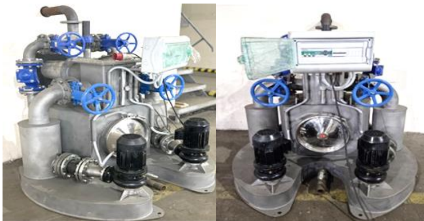
Рисунок 1 – Канализационная насосная станция
