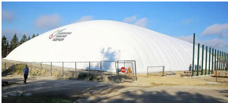
Рисунок 2 – Строительство современного теннисного центра в г. Гродно
