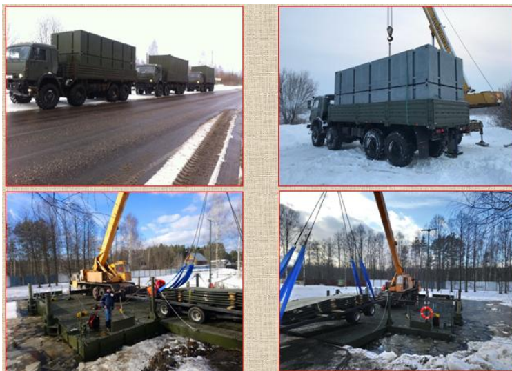
Рисунок 23 – Мобильный плашкоут для выполнения строительно-монтажных работ на воде
