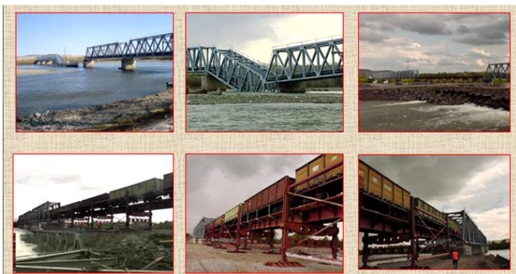
Рисунок 4 – Восстановление разрушенного железнодорожного моста через р. Абакан у ст. Камышта
