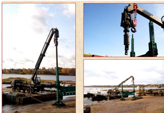
Рисунок 21 – Установка для завинчивания свай УЗС-85
