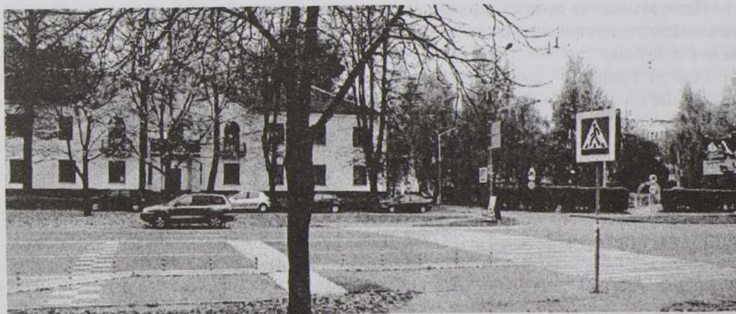
Рисунок 2 – Сужение проезжей части в зоне пешеходного перехода делинаторами
