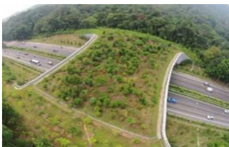
Рисунок 1 – Организация прохождения диких животных через автомобильную дорогу
