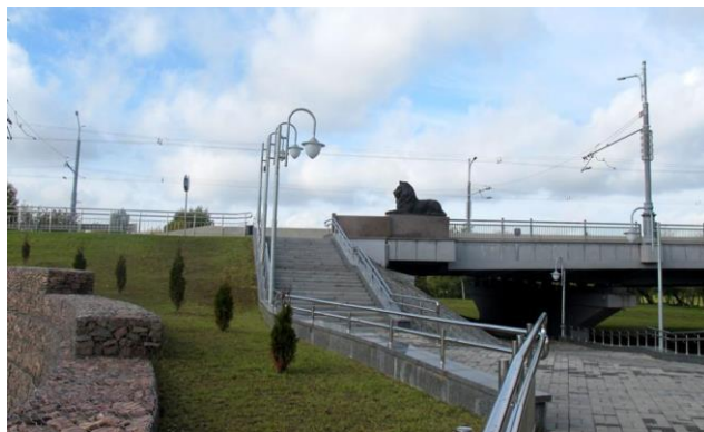
Рисунок 2 – Массивные удерживающие подпорные стены из коробчатых габрионов при реконструкции моста через р. Днепр в г. Могилеве
