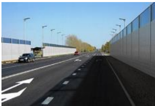
Рисунок 1 – Шумозащитные экраны вдоль автомобильной дороги
