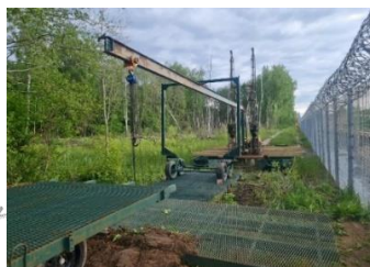
Рисунок 2 – Фотография подвоза тележки с пролетным строением моста
