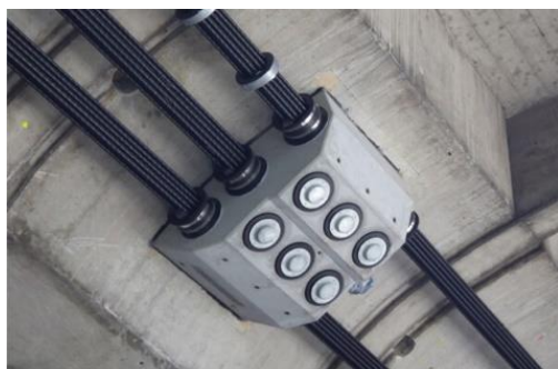
Рисунок 1 – Общий вид анкерных блоков-упоров
