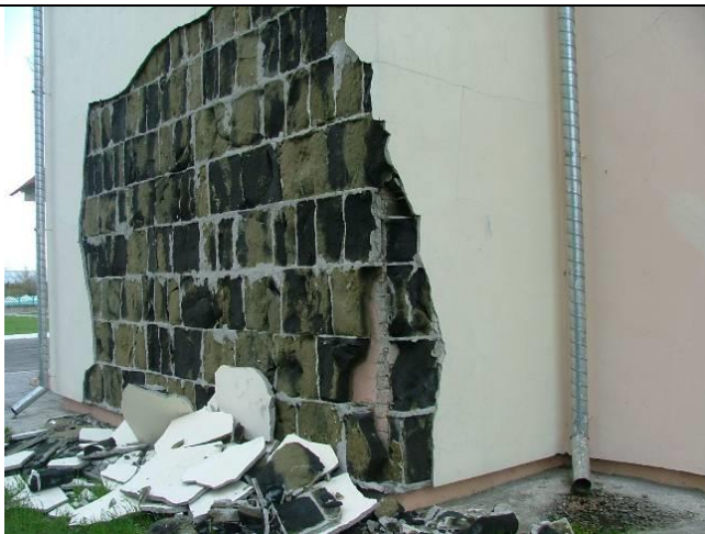
Рисунок В.7 – Фрагмент наружной стены с выполненной термореновацией
