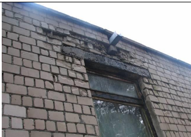
Рисунок В.19 – Фрагмент водоотвода с кровли
