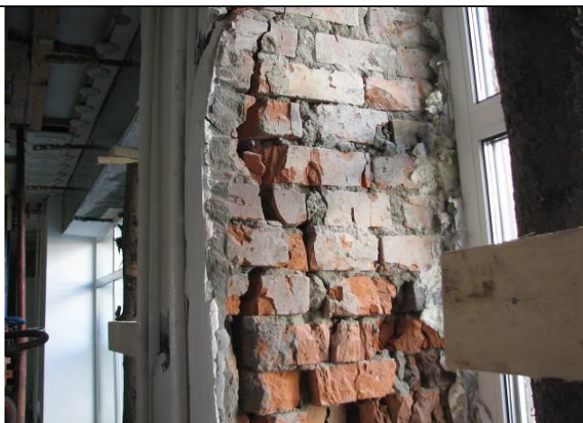
Рисунок В.11 – Фрагмент простенка наружной кирпичной стены
