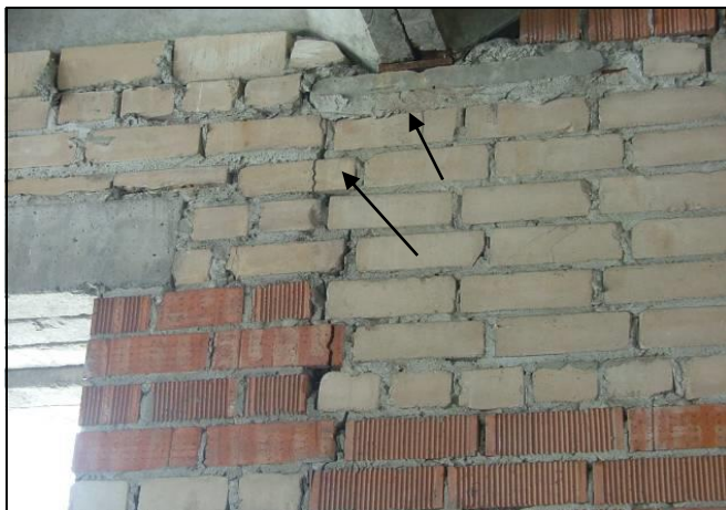
Рисунок В.5 – Фрагмент наружной кирпичной стены
