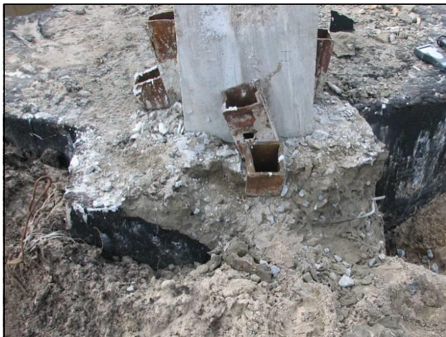
Рисунок В.2 – Фрагмент оголовка фундамента ж/б стойки
