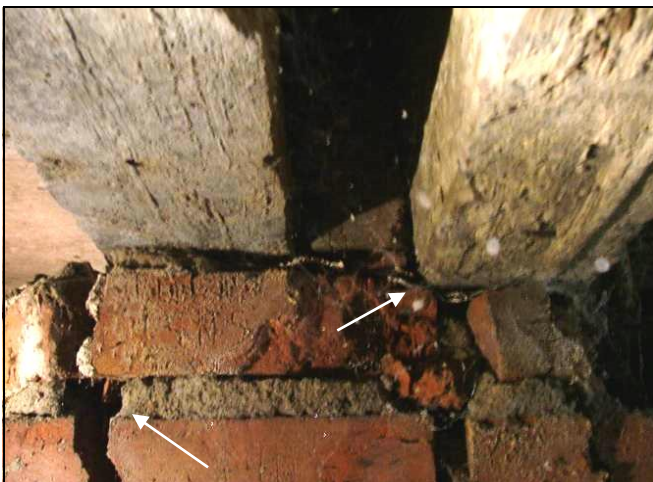
Рисунок В.9 – Фрагмент участка опирания прогона
