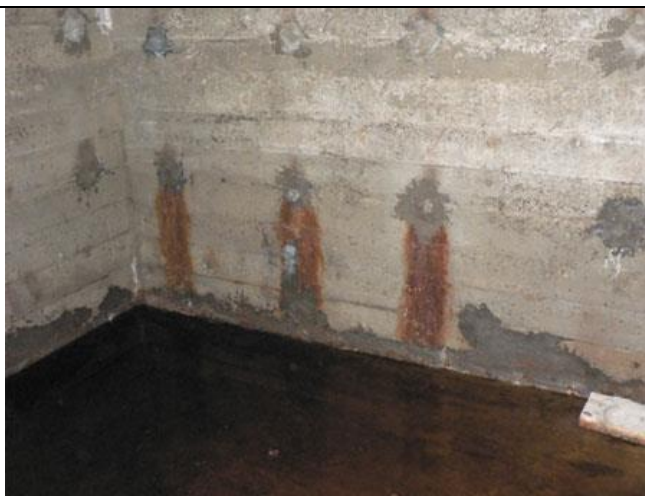
Рисунок В.3 – Фрагмент стены подвала
