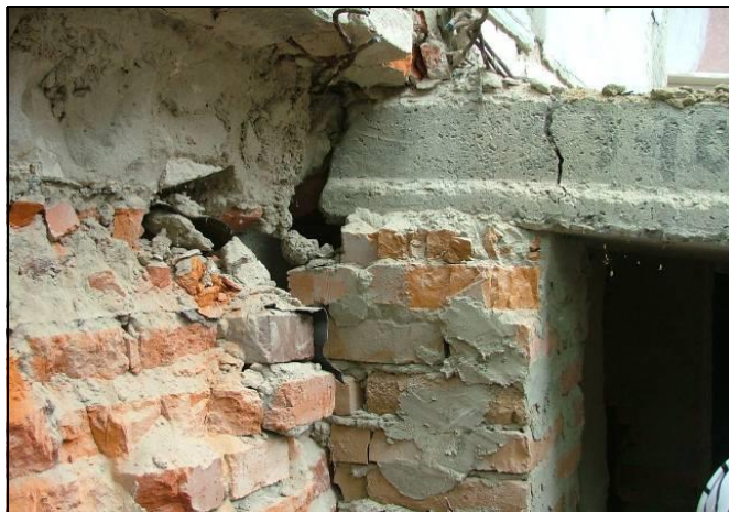
Рисунок В.10 – Фрагмент конструкций подвальной части
