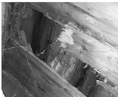
Рисунок 1 – Общий вид здания прихода храма Успения Пресвятой Богородицы в д. Кошевичи Петриковского района и фрагменты деревянных конструкций (нижних венцов и междуэтажного перекрытия крестильни), поврежденных дереворазрушающими грибами
