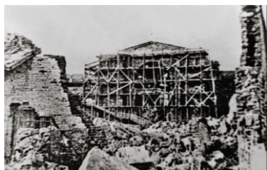
Рисунок 3 – Восстановление железнодорожного вокзала, 1943 г.
