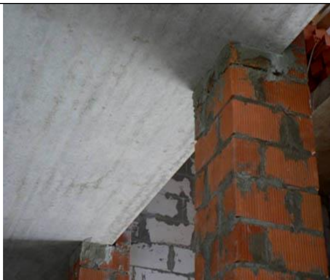
Рисунок 4.32 – Фрагмент кирпичных столбов
