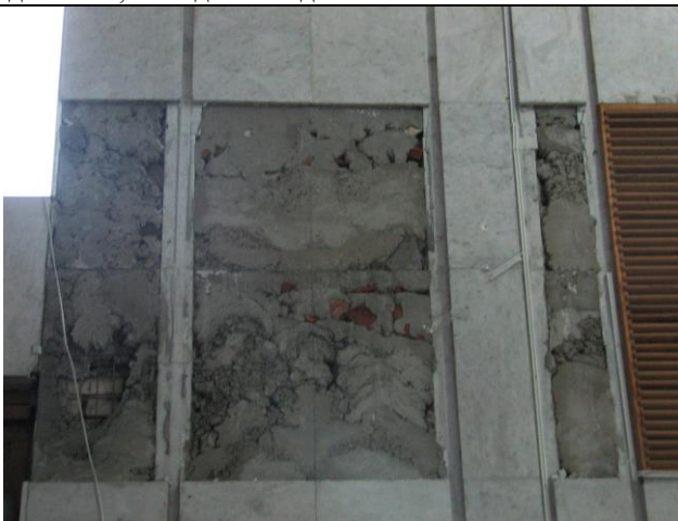
Рисунок 4.21 – Фрагмент облицовки наружной кирпичной стены со стороны помещения
