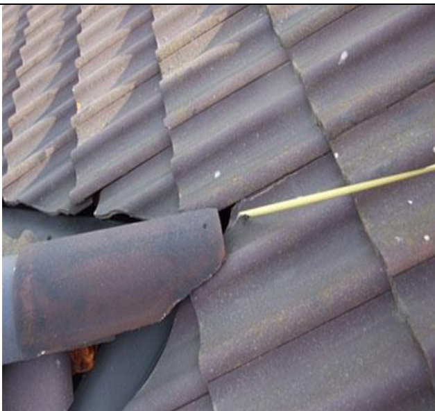
Рисунок 4.84 – Фрагмент наружного водоотвода с кровли
