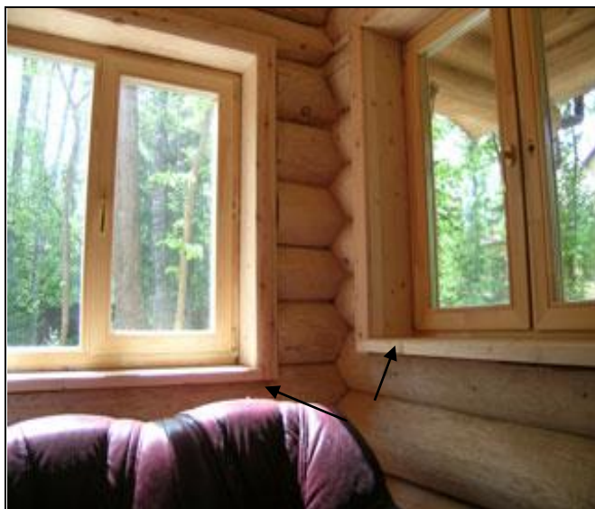
Рисунок 4.98 – Фрагмент деревянных оконных блоков
