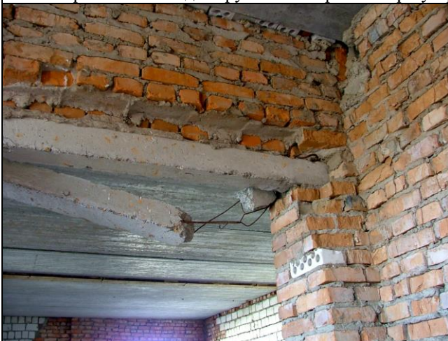
Рисунок 4.39 – Фрагмент дверной перемычки
