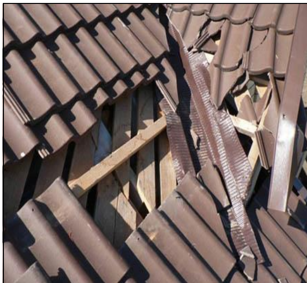
Отсутствие бруска опоры желобка; сплошного настила ендовы, крепления черепицы непосредственно у ендовы
