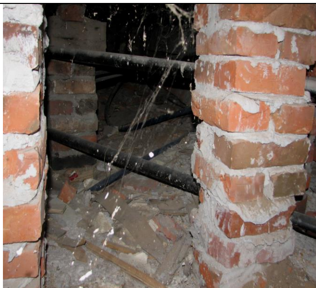
Рисунок 4.92 – Фрагмент опорных кирпичных столбиков под лаги
