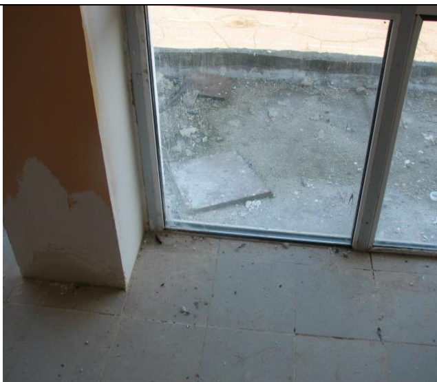
Рисунок 4.93 – Фрагмент оконного блока ПВХ
