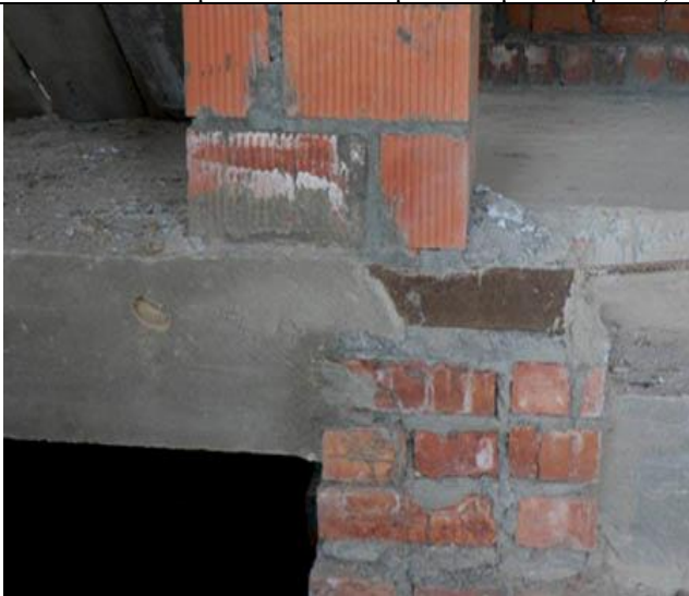
Рисунок 4.33 – Фрагмент кирпичного столба и внутренней несущей стены
