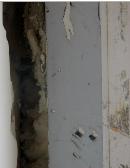
Рисунок 4.94 – Фрагмент оконного блока ПВХ
