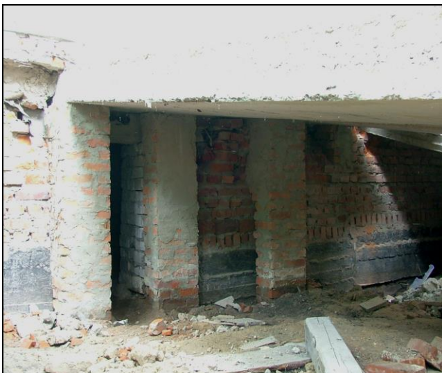
Рисунок 4.50 – Фрагмент конструкций подвальной части
