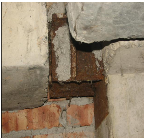
Рисунок 4.42 – Фрагмент опорного столика на участке стыковки ригеля и колонны
