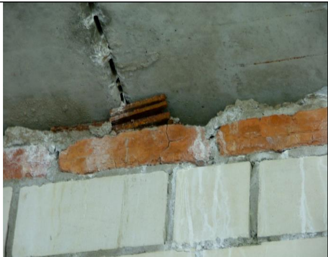
Рисунок 4.52 – Фрагмент плит перекрытия пустотного настила
