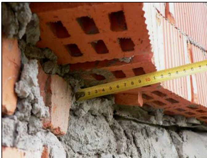
Рисунок 4.16 – Фрагмент кирпичной стены
