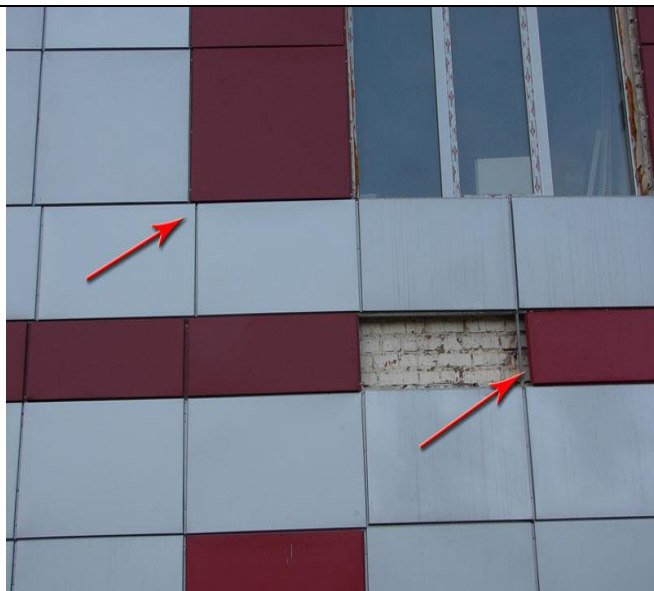
Рисунок 4.20 – Фрагмент облицовки наружной кирпичной стены
