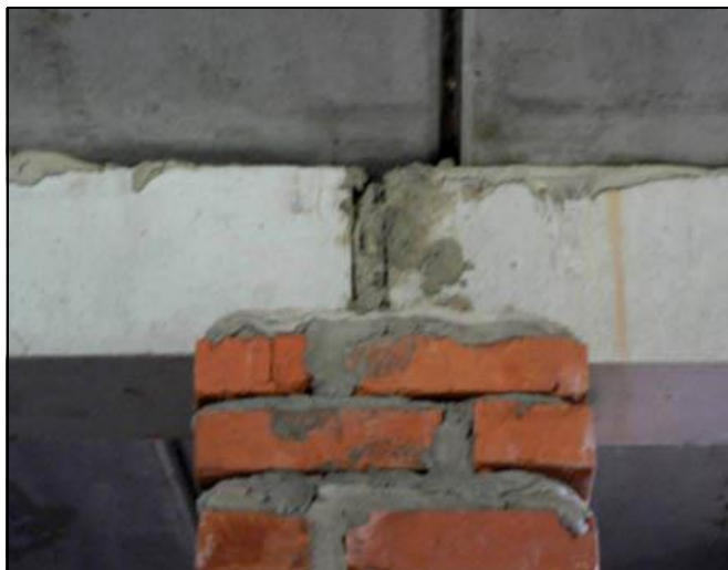
Недостаточная ширина опирания перемычки – до 30 мм
