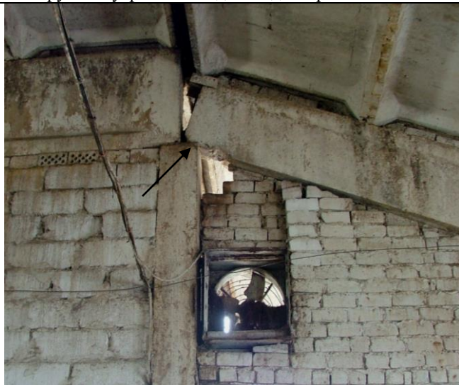
Рисунок 4.45 – Фрагмент балок покрытия
