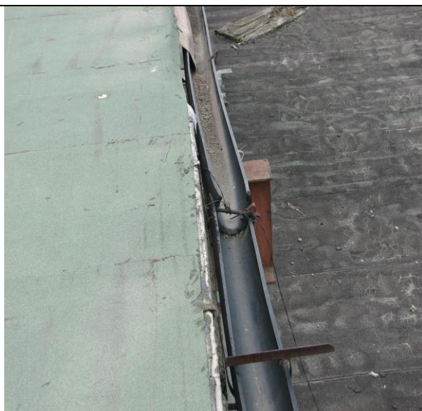
Рисунок 4.80 – Фрагмент наружного водоотвода с кровли
