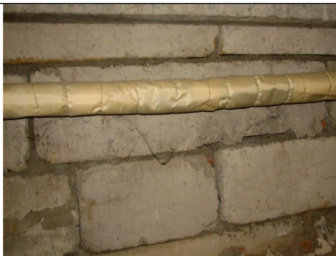
Рисунок 4.9 – Фрагмент наружной стены подвала
