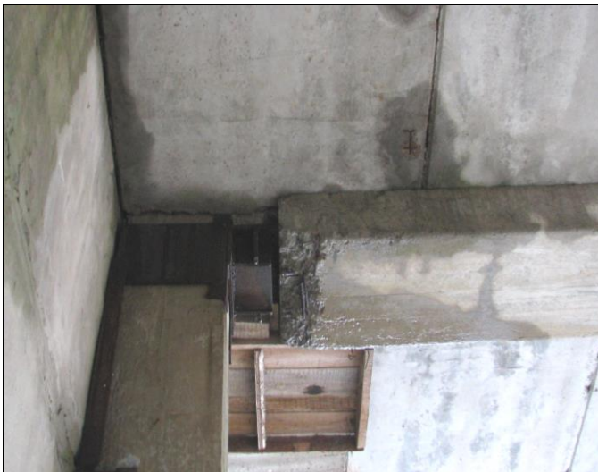
Рисунок 4.31 – Фрагмент крайней ж/б колонны
