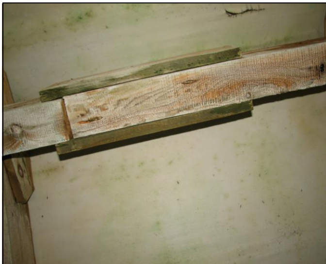
Рисунок 4.70 – Фрагмент узла стыковки элементов прогона по длине
