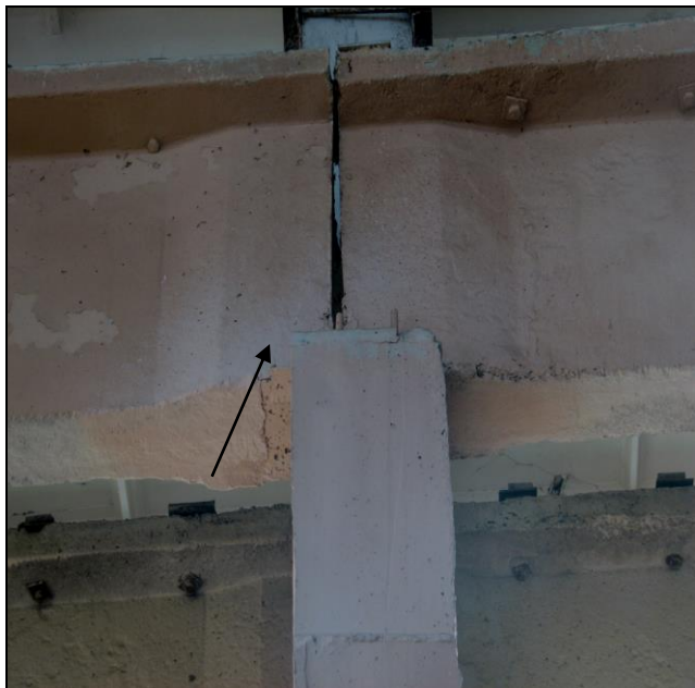
Рисунок 4.62 – Фрагмент ж/б подкрановых балок
