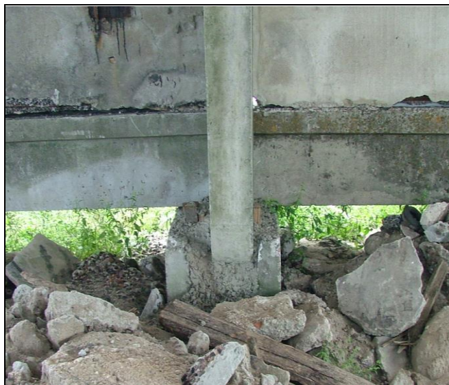
Рисунок 4.7 – Фрагмент фундамента под полураму
