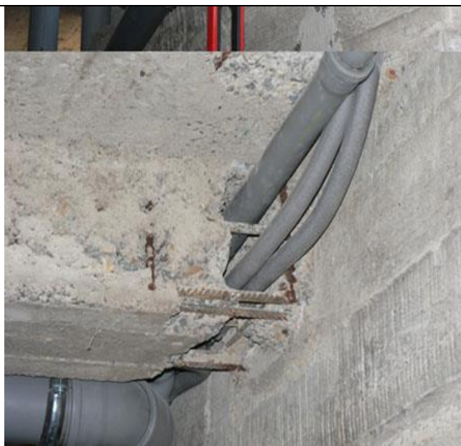
Рисунок 4.40 – Фрагмент монолитной ж/б балки перекрытия
