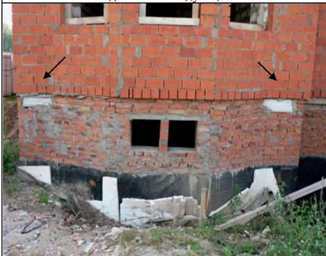
Рисунок 4.19 – Фрагмент наружной кирпичной стены
