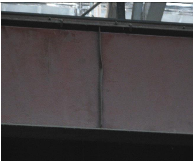
Рисунок 4.61 – Фрагмент стальной подкрановой балки
