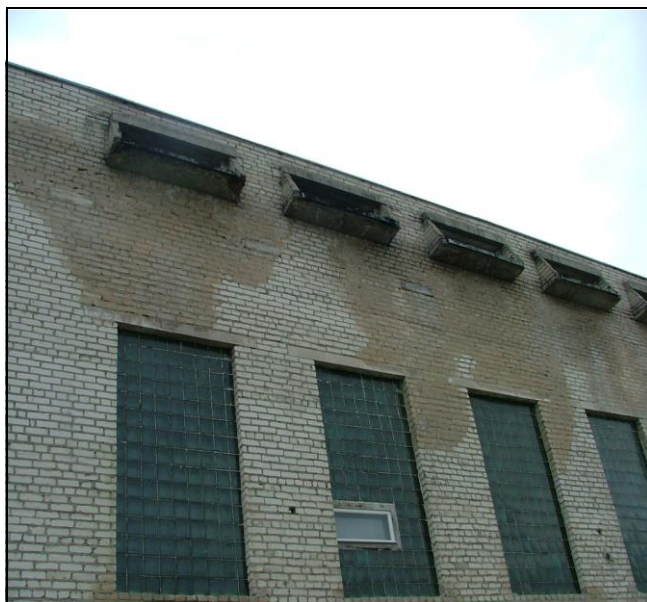
Рисунок 4.27 – Фрагмент наружной стены
