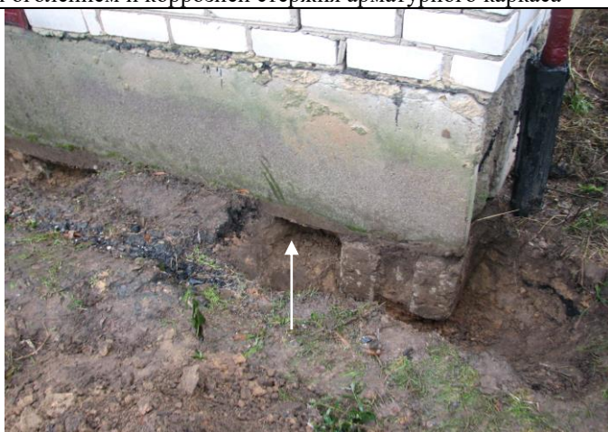
Рисунок 4.5 – Фрагмент ленточного фундамента из блоков ФБС
