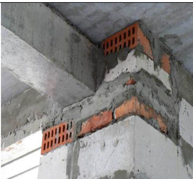
Рисунок 4.25 – Фрагмент наружной стены на участке опирания прогона
