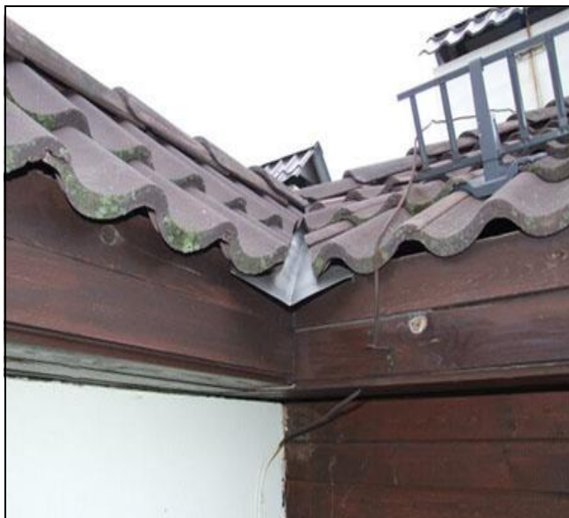
Отсутствует аэроэлемент свеса с решеткой от проникновения птиц и грызунов
