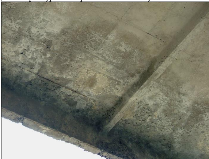
Рисунок 4.55 – Фрагмент ж/б ребристой плиты покрытия
