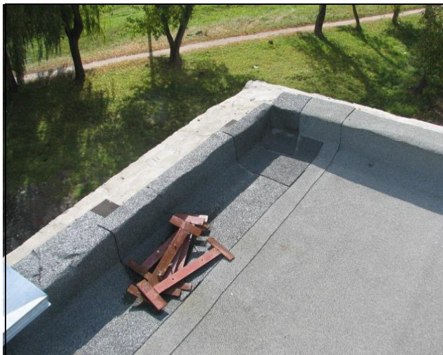
Отсутствие козырьков из оцинкованной стали по парапетной части наружной стены
