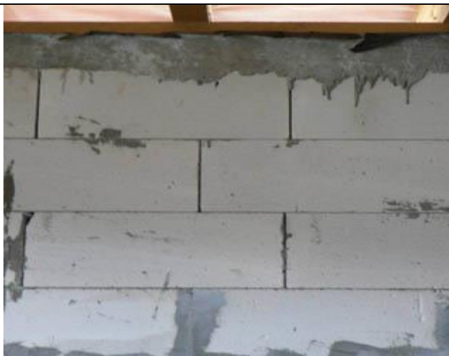
Рисунок 4.14 – Фрагмент кладки стены из блоков ПГС
