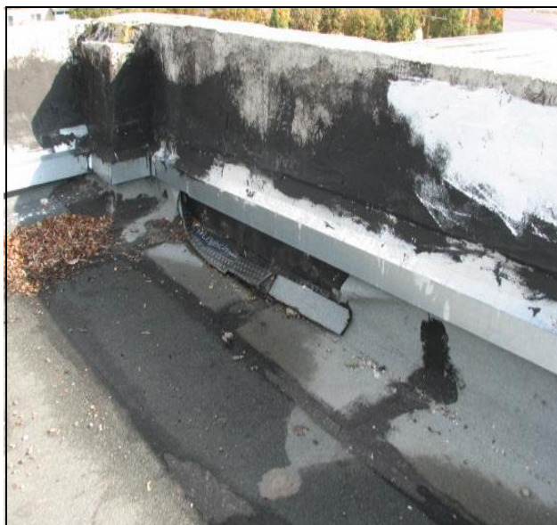
Рисунок 4.75 – Фрагмент рулонной кровли
