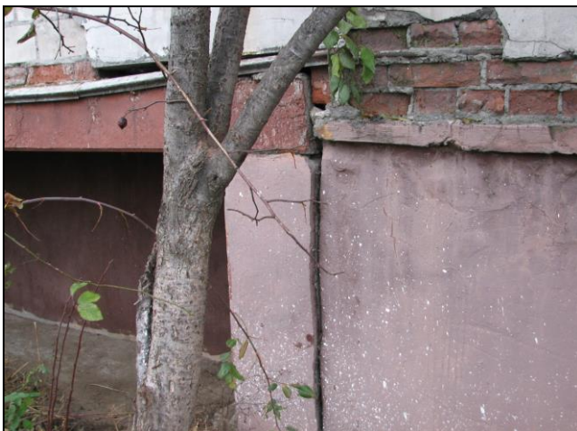
Рисунок 4.18 – Фрагмент наружной кирпичной стены
