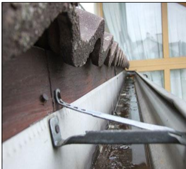
Рисунок 4.79 – Фрагмент наружного водоотвода с кровли
