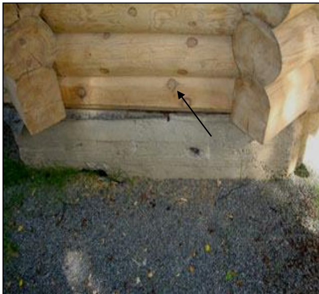
Рисунок 4.22 – Фрагмент наружной бревенчатой стены
