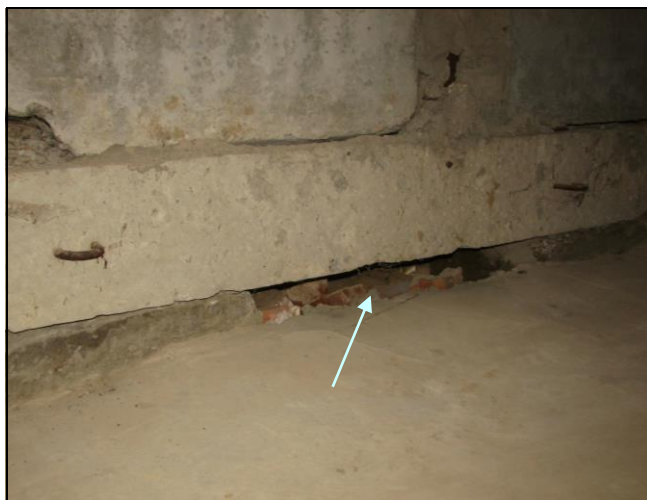
Рисунок 4.2 – Фрагмент свайного фундамента
