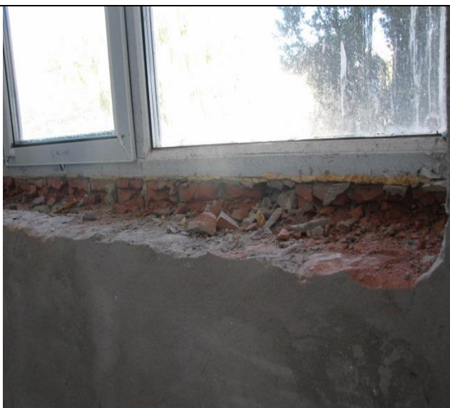
Рисунок 4.97 – Фрагмент оконного блока ПВХ
