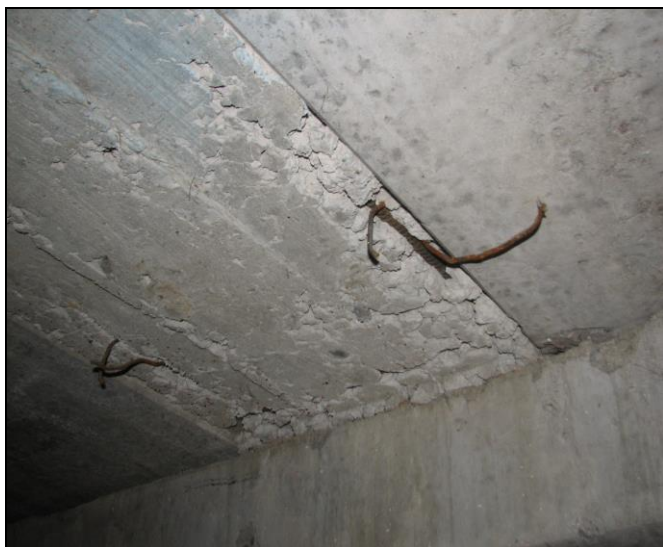
Рисунок 4.54 – Фрагмент монолитного участка перекрытия над подвалом
