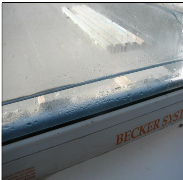
Рисунок 4.95 – Фрагмент оконного блока ПВХ
