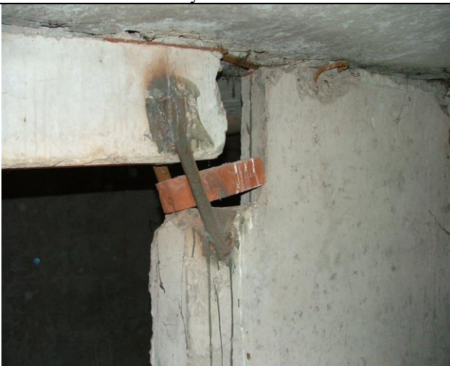
Рисунок 4.17 – Фрагмент внутренней стены, выполненной из сборных ж/б панелей
