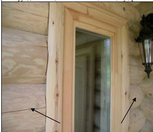
Рисунок 4.23 – Фрагмент наружной бревенчатой стены
