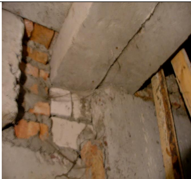
Рисунок 4.24 – Фрагмент стены на участке опирания прогонов
