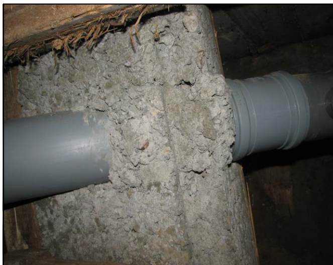
Рисунок 4.6 – Фрагмент столбчатого монолитного бетонного фундамента
