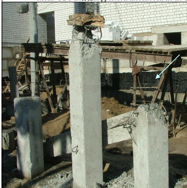
Рисунок 4.3 – Фрагмент свайного поля
