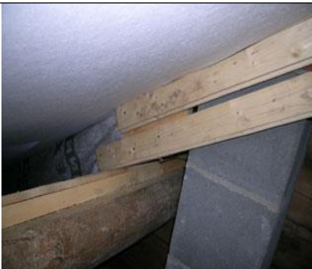
Рисунок 4.72 – Фрагмент стропильной ноги
