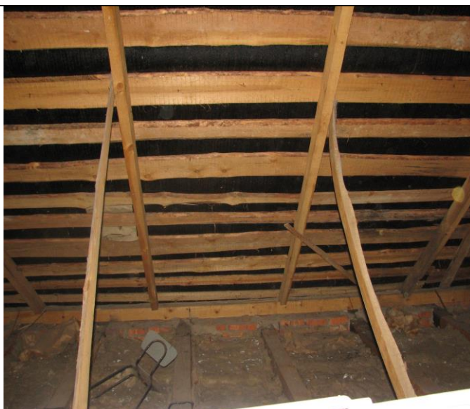
Рисунок 4.68 – Фрагмент стропильной системы
