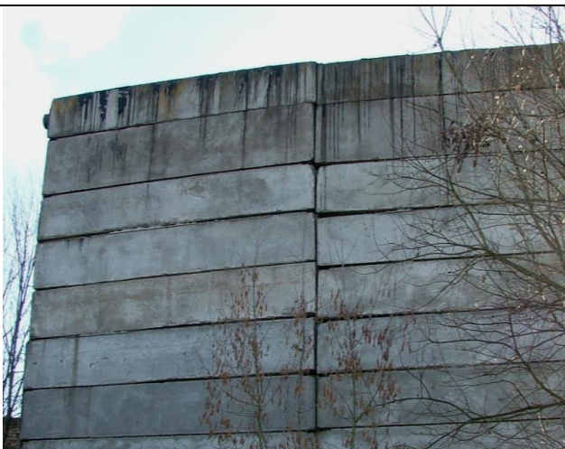
Рисунок 4.28 – Фрагмент стены, выполненной из керамзитобетонных стеновых панелей
