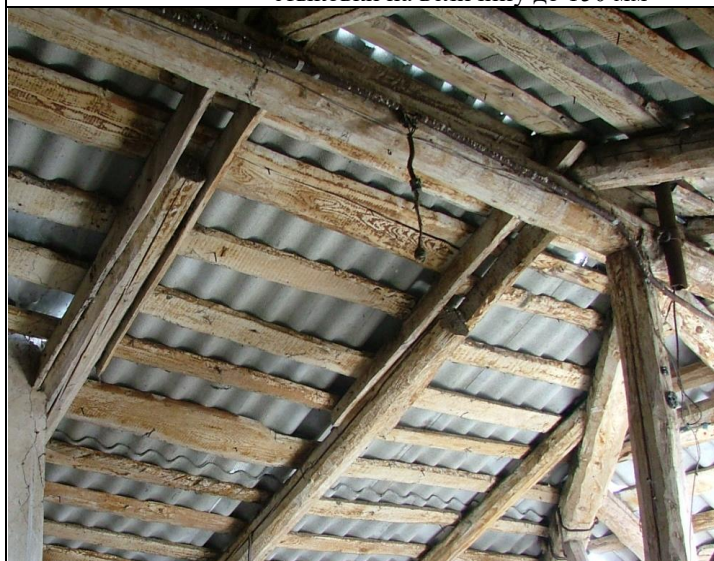
Рисунок 4.71 – Фрагмент стропильной системы
