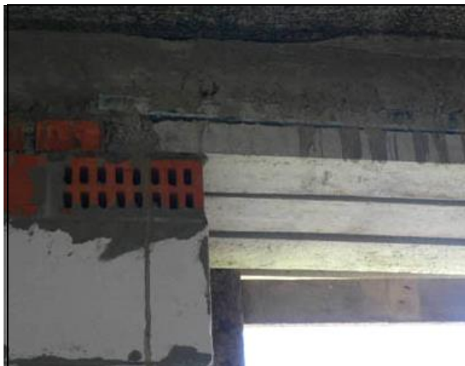
Рисунок 4.35 – Фрагмент узла опирания оконных перемычки
