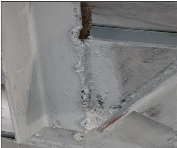
Рисунок 4.66 – Фрагмент узла стыковки стальных элементов
