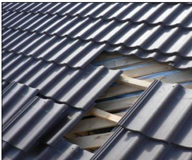
Рисунок 4.83 – Фрагмент кровли из керамической черепицы
