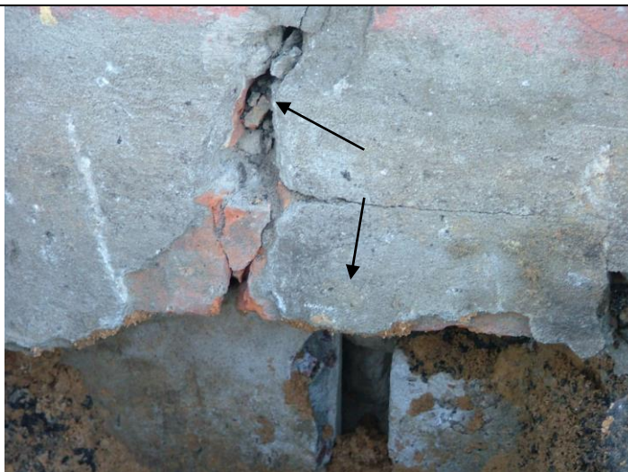
Рисунок 4.8 – Фрагмент ленточного фундамента из блоков ФБС
