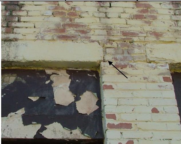
Недостаточная ширина опирания перемычки – до 30 мм
