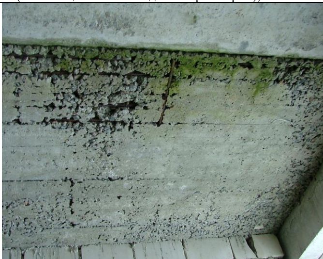
Рисунок 4.53 – Фрагмент плиты перекрытия пустотного настила
