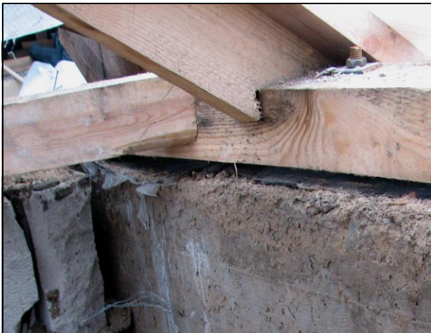
Рисунок 4.67 – Фрагмент узла стыковки стропильной ноги и мауэрлата
