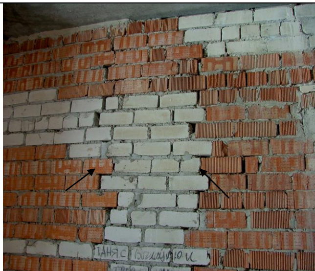
Рисунок 4.11 – Фрагмент кирпичной стены
