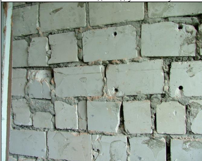
Рисунок 4.13 – Фрагмент кладки стены из камня силикатного
