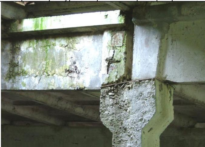
Разрушение и отслаивание защитного слоя бетона балки; оголение и коррозия конструктивной арматуры в опорной зоне балки; отдельные
