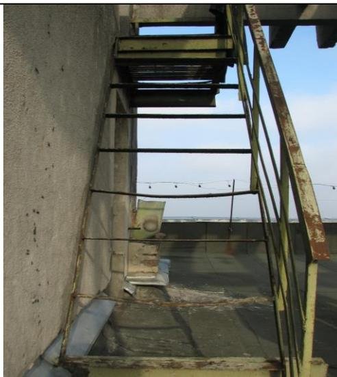
Прогиб отдельных ступеней на величину до 40 мм; разрушение и отслаивание защитного покрытия элементов лестницы на многочисленных участках; поверхностная коррозия элементов лестницы на многочисленных участках
