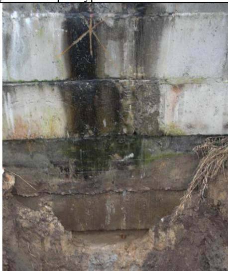
Высолы бетона на многочисленных участках; выкрашивание заделки
