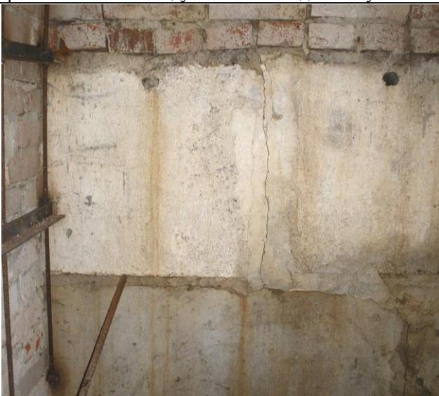
Вертикальная трещина в средней части блока ФБС шириной раскрытия до 1,0 мм
