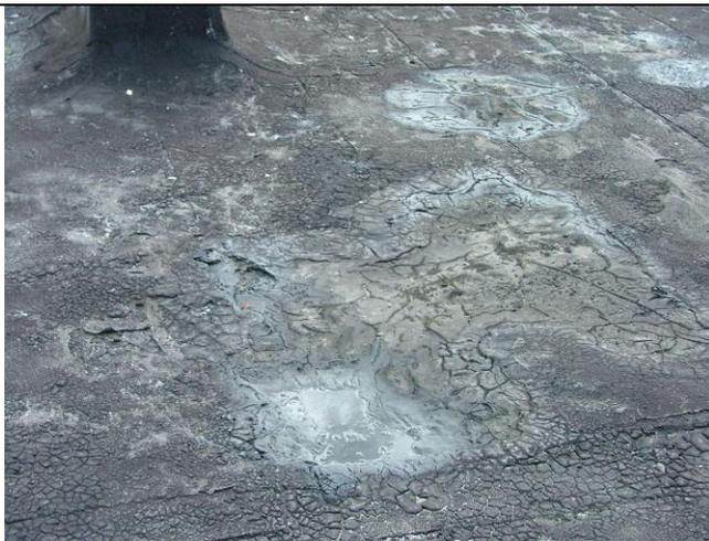
Растрескивание верхнего покровного слоя рулонного покрытия; отслаивание отдельных фрагментов верхнего слоя гидроизоляционного ковра; просадки кровельного ковра и скопление в них воды
