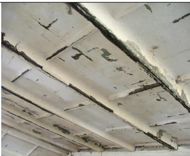
Отслаивание и разрушение бетона защитного слоя на многочисленных участках; оголение и коррозия рабочей арматуры продольных и поперечных ребер; оголение и коррозия арматуры полок плит; продольная трещина по нижней поверхности поперечного ребра плиты шириной раскрытия до 5,0 мм
