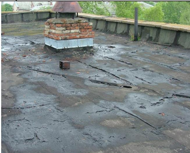
Расстройство швов в местах наклейки одной полосы рулонного материала на другую; отрыв и отслаивание верхних слоев на отдельных участках; разрывы кровельного ковра; прорастание растений в местах пропуска трубы
