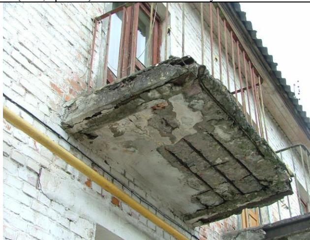
Разрушение и отслаивание защитного слоя бетона на многочисленных участках; размораживание бетона по боковым поверхностям плиты на глубину до 50 мм; отдельные трещины по нижней поверхности в месте расположения арматуры шириной раскрытия до 2,0 мм; оголение и коррозия
