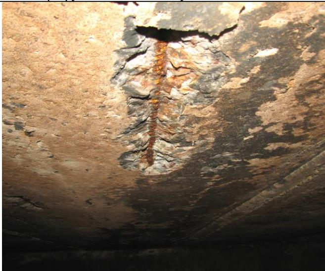
Отслаивание и разрушение бетона защитного слоя; оголение и пластинчатая коррозия стержня рабочей арматуры; сколы бетона на глубину до 20 мм на отдельных участках
