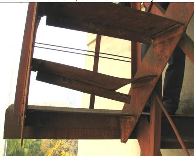
Деформация ступени; разрушение и отслаивание защитного покрытия на многочисленных участках; поверхностная коррозия элементов лестницы на многочисленных участках
