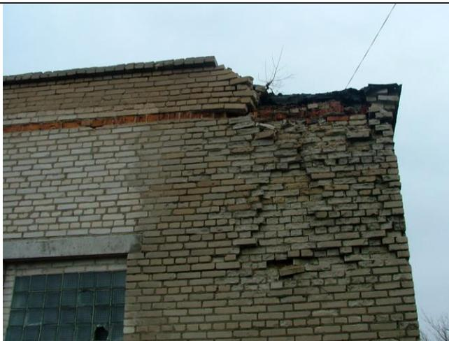
Разрушение кладки в верхней части (отдельные кирпичи на грани обрушения); размораживание кладки на величину до 100 мм в верхней части, до 50 мм на многочисленных участках; выкрашивание раствора из швов кладки на глубину до 20 мм на отдельных участках; переувлажнение кладки и биоповреждения (мох) на многочисленных участках
