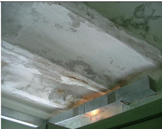
Отслаивание и разрушение отделочных покрытий по нижней поверхности стальных балок и сводам; поверхностная коррозия нижней поверхности стальных балок на отдельных участках;
