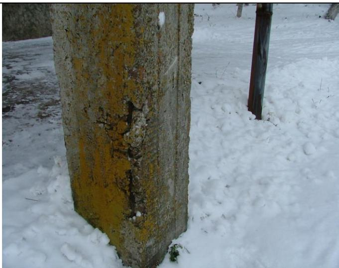
Недоуплотнение бетона (раковины) на участке расположения стержня рабочей арматуры на глубину до 20,0 мм; оголение и коррозия стержней рабочей и конструктивной арматуры; биоповреждения (лишайник)
