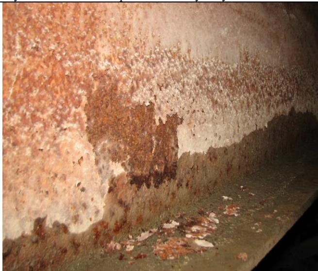
Разрушение защитного окрасочного покрытия; поверхностная равномерная коррозия, начало развития пластинчатой коррозии на отдельных участках
