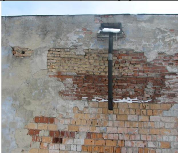
Отслаивание и разрушение штукатурного слоя; размораживание кладки, выполненной из кирпича силикатного и керамического полнотелого на глубину до 30 мм, из камня керамического – на глубину до 15 мм
