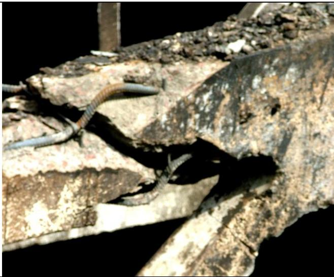
Разрыв верхнего пояса, искривление арматуры вследствие воздействия высоких температур; закопченность поверхности повсеместно
