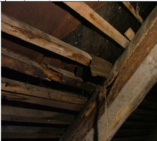
Увлажнение обрешетки; разрушение дереворазрушающими грибами (гниль) обрешетки; поверхностная равномерная коррозия стальных листов
