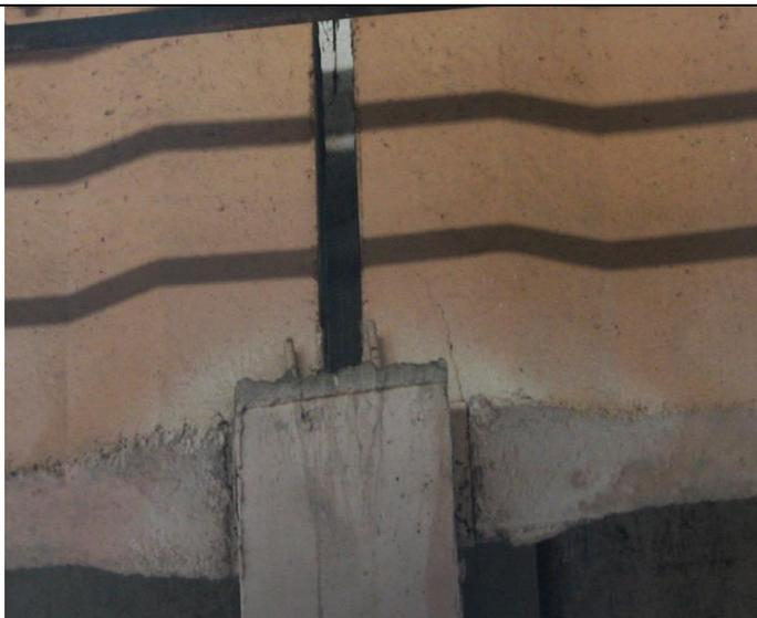
Наклонная трещина по боковой поверхности в опорной зоне от края закладной детали шириной раскрытия до 0,3 мм, длиной до 200 мм; сколы бетона по углам нижней поверхности на глубину до 15 мм
