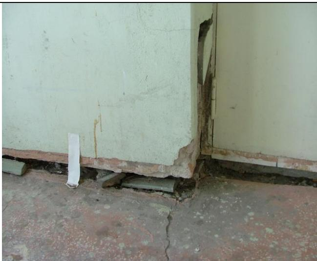
Просадка пола на величину до 70 мм; отдельные трещины по
