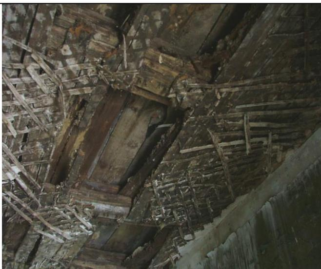
Полное разрушение штукатурного слоя; разрушение подшивки
