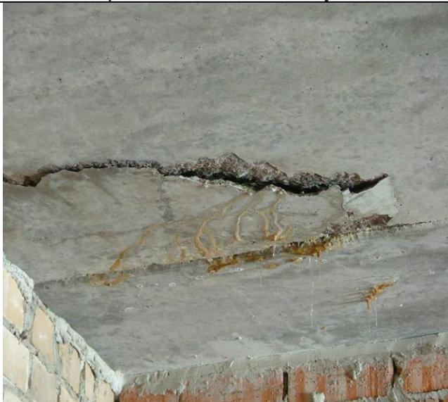
Отслаивание бетона по нижней поверхности плиты, отдельные
