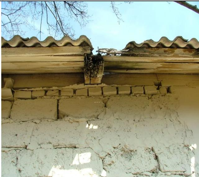
Разрушение древесины подшивки дереворазрушающими грибами (гниль);
