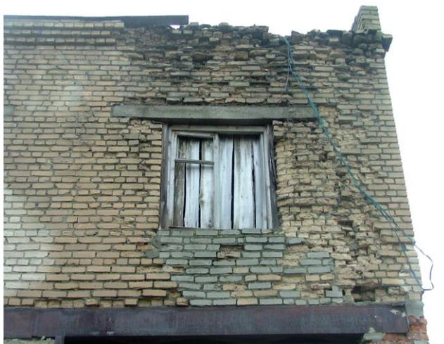
Размораживание кладки в верхней части стены на глубину до 120 мм;
