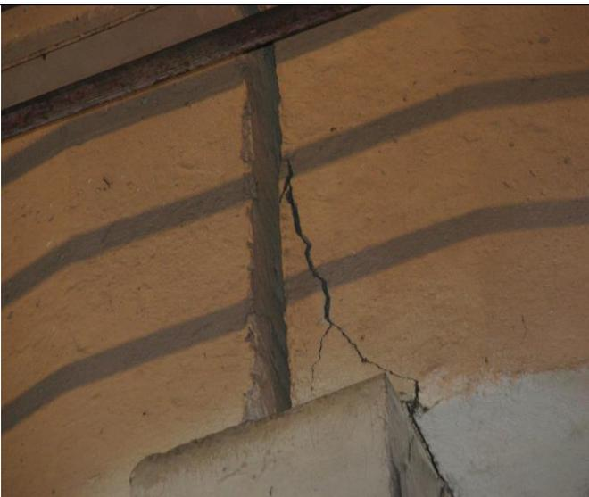
Наклонная трещина в опорной зоне шириной раскрытия до 5,0 мм
