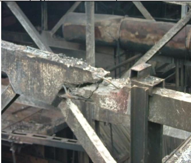
Разрушение бетона верхнего пояса, разрыв верхнего пояса, смещение участков верхнего пояса на величину до 30 мм вследствие воздействия высоких температур; закопченность поверхности
