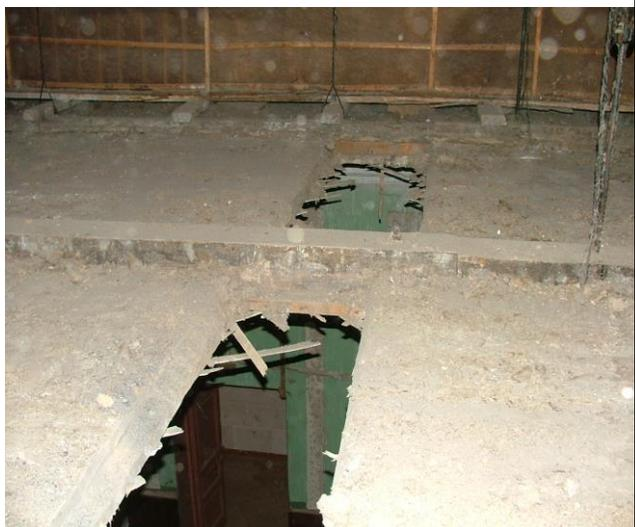
Полное разрушение и обрушение подшивки между балками
