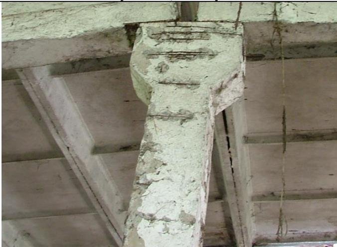
Отслаивание и разрушение бетона защитного слоя на многочисленных участках; оголение и коррозия поперечных арматурных стержней (хомутов); многочисленные сколы по ребру на глубину до 30,0 мм
