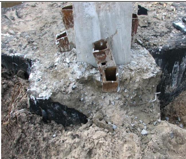
Размораживание бетона на глубину до 100 мм,
