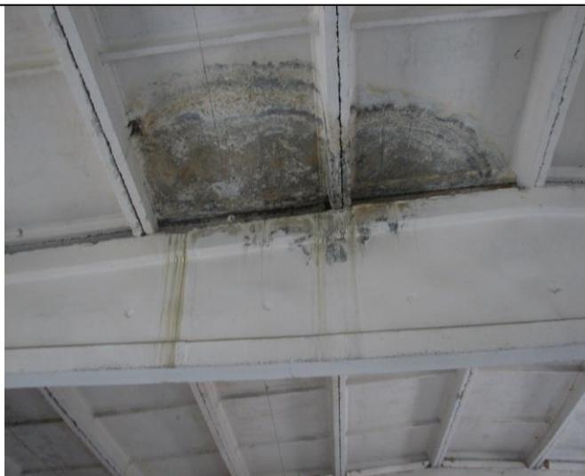
Следы увлажнения плит и балки покрытия; разрушение отделочного покрытия по нижней поверхности на участке увлажнения и боковой поверхности балки
