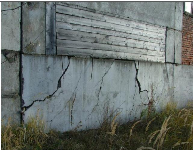
Наклонные сквозные трещины по стеновой панели шириной раскрытия до 10 мм, выгиб панели относительно вертикальной оси на величину до 50 мм, полное разрушение заделки швов между панелями
