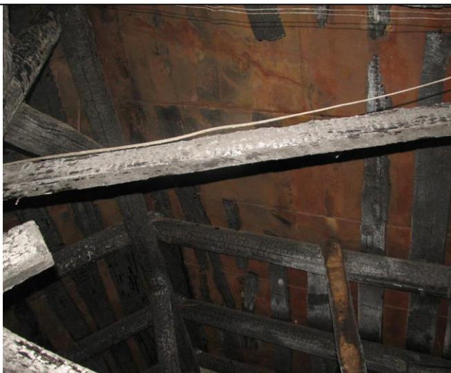
Полное разрушение обрешетки кровли на многочисленных участках вследствие огневого воздействия; обугливание и частичное разрушение элементов стропильной системы
