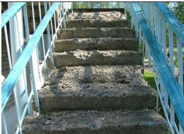
Размораживание бетона ступеней на величину до 40 мм, по отдельным ступеням
