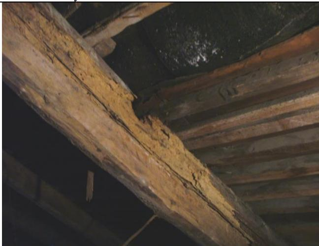
Массовые повреждения древесины стропильной ноги древоточцами на многочисленных участках, полное разрушение отдельных участков на глубину до 70 мм; продольная трещина по боковой поверхности шириной раскрытия до 5,0 мм
