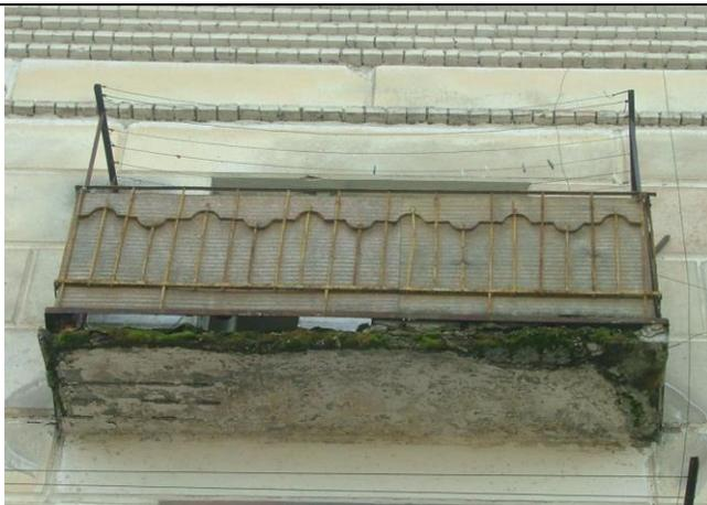
Отслаивание и разрушение защитного слоя бетона на многочисленных участках; разрушение бетона на всю толщину плиты на многочисленных участках; оголение и коррозия арматуры; следы увлажнения и биоповреждения (мох, грибок) на многочисленных участках
