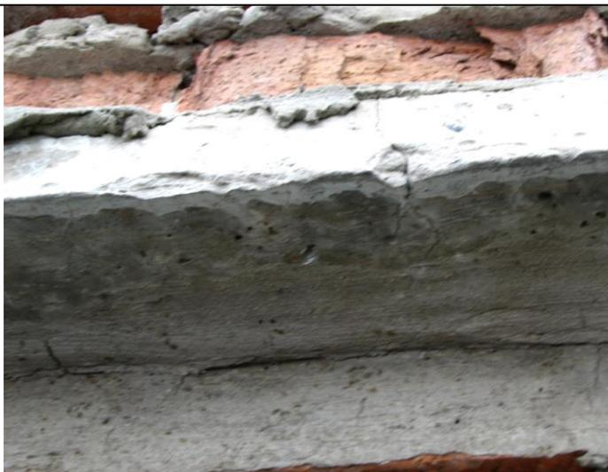
Нормальная трещина по боковой поверхности шириной раскрытия до 0,3 мм, переходящая на нижнюю поверхность; сколы бетона на глубину до 20 мм на отдельных участках; недоуплотнение бетона (раковины) на глубину до 5 мм на отдельных участках
