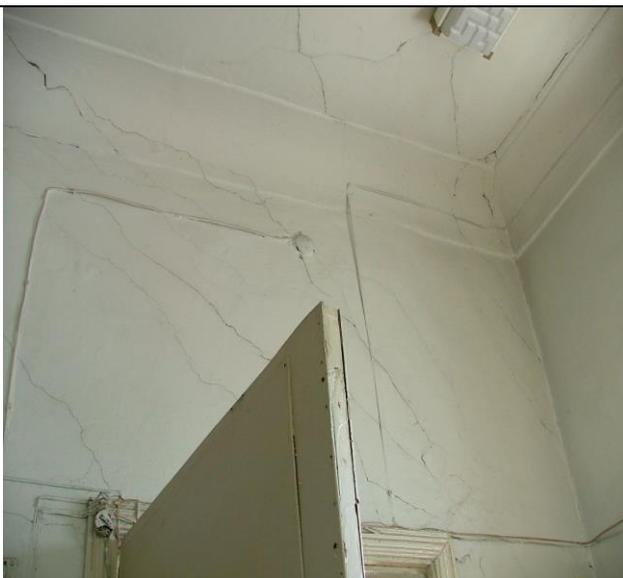
Многочисленные трещины различного характера по штукатурному слою перегородки, переходящие на потолочную часть перекрытия
