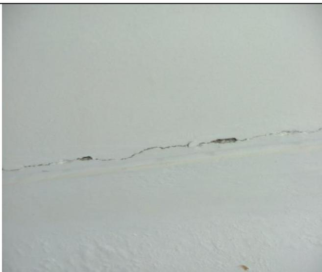
Продольная трещина по заделке шва между плитами шириной раскрытия
