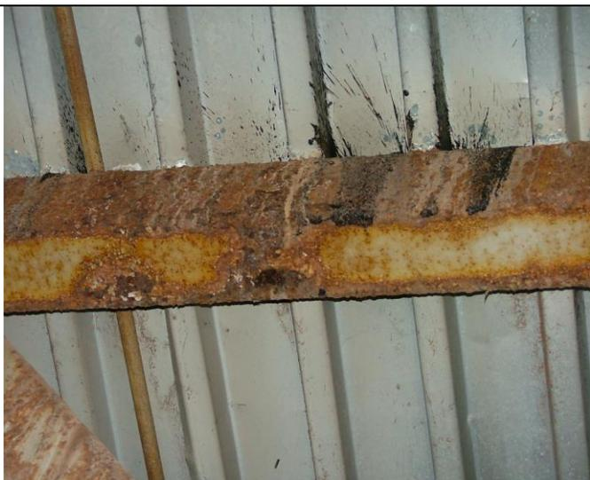
Отслаивание и разрушение защитного покрытия; поверхностная равномерная коррозия на многочисленных участках, на отдельных – начало развития пластинчатой коррозии
