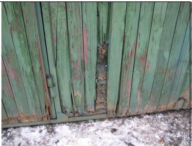
Разрушение обшивки ворот на отдельных участках; частичное разрушение досок обшивки в нижней части дереворазрушающими грибами (гниль); смятие и выпадение утеплителя на участке отсутствия доски обшивки; разрушение окрасочного покрытия на многочисленных участках
