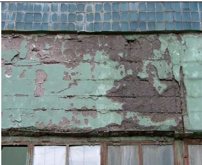
Размораживание и разрушение бетона стеновой панели на глубину до 20 мм, оголение и коррозия стержней арматурной сетки; выкрашивание заделки шва между панелями на многочисленных участках
