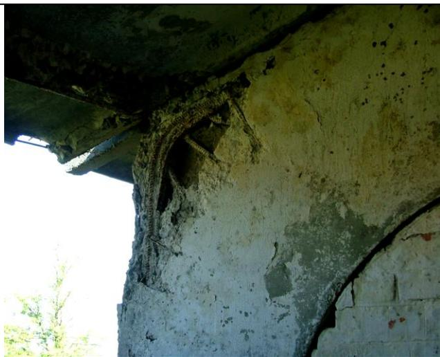
Отслаивание и разрушение защитного слоя бетона на участке перехода
