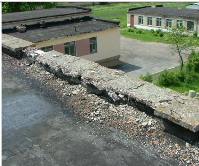
Размораживание и разрушение бетона парапетных ж/б плит на всю толщину на глубину до 100 мм, оголение и коррозия арматуры плит; биоповреждения (мох, лишайник) бетона
