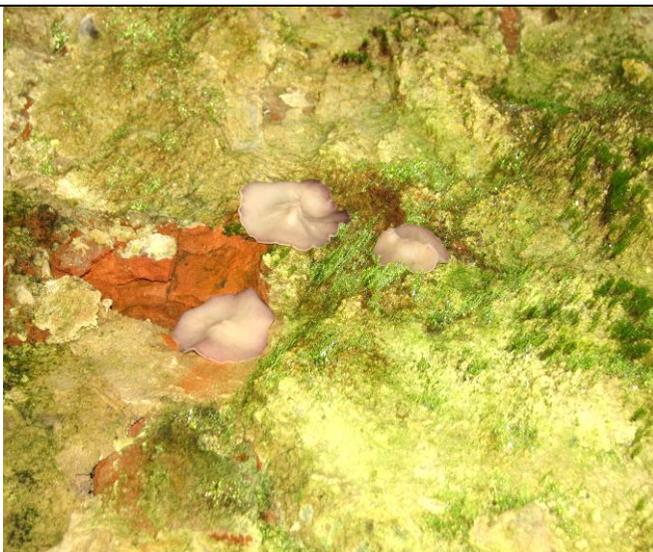
Увлажнение кладки, размораживание кладки до 15 мм;
