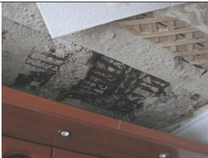
Разрушение защитного слоя; пластинчатая коррозия арматурных стержней
