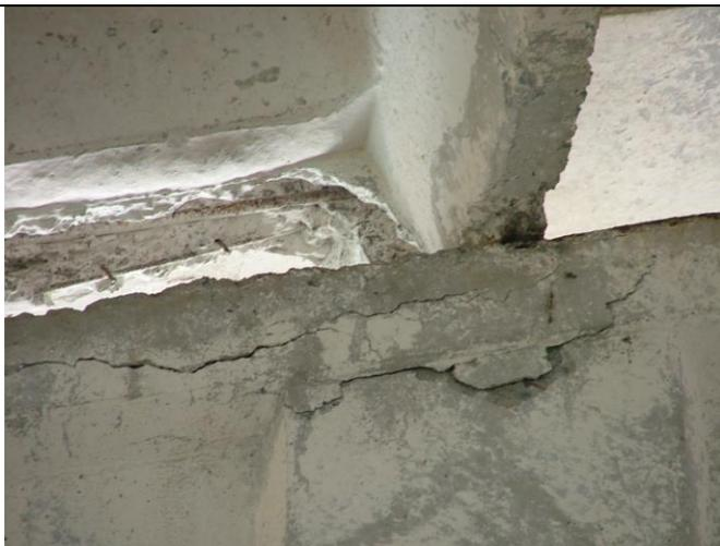
Отслаивание бетона в опорной зоне плиты покрытия; продольная трещина по боковой поверхности на участке расположения арматуры шириной раскрытия до 3,0 мм; разрушение отделочного покрытия (побелки) на многочисленных участках; оголение и поверхностная неравномерная коррозия участков стержней арматуры поперечных опорных ребер плит
