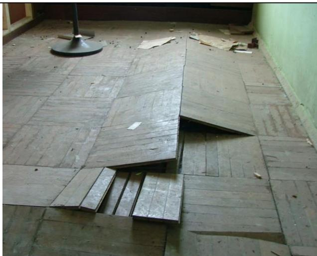
Рассыхание и вспучивание покрытия на величину до 100 мм; рассыхание покрытия по швам рисунка, а также между паркетными планками (клепками); разрушение лакового покрытия
