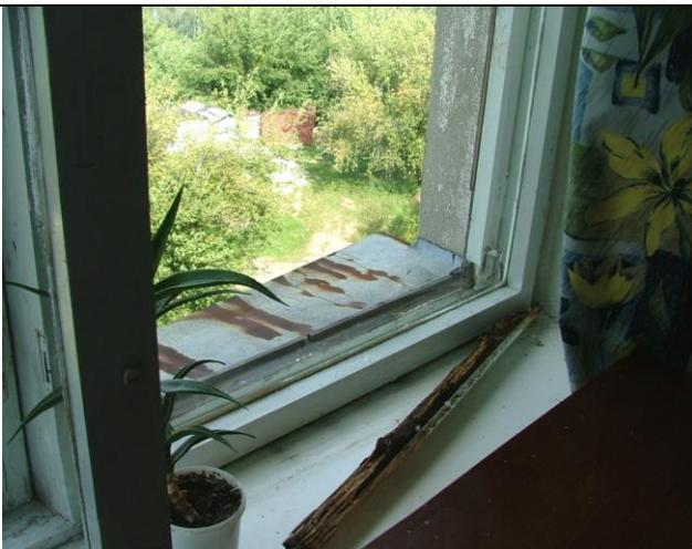
Разрушение дереворазрушающими грибами (гниль) древесины нижней части оконной коробки; разрушение защитного покрытия, коррозия металла подоконного слива
