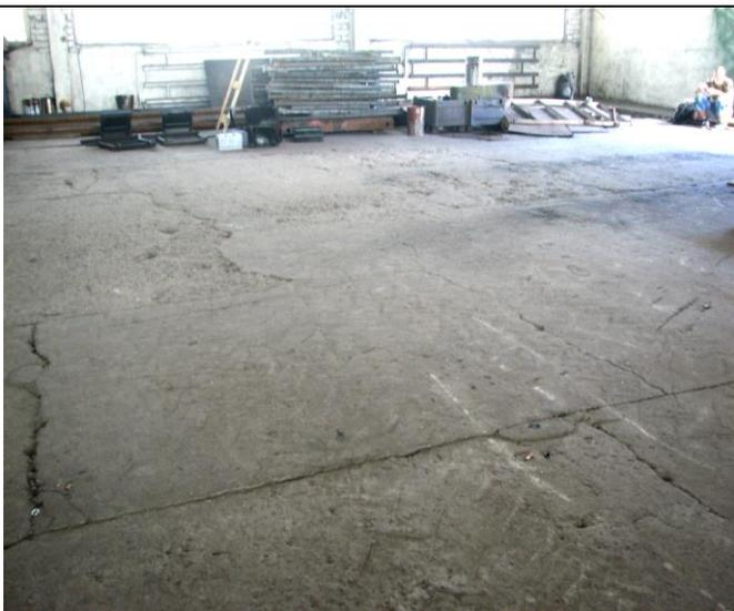
Многочисленные трещины шириной раскрытия до 7,0 мм; сколы бетона на глубину до 15 мм на отдельных участках; разрушение поверхностного слоя на глубину до 5,0 мм на многочисленных участках
