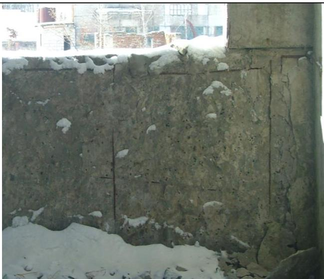
Повсеместное размораживание и отслаивание бетона защитного слоя;
