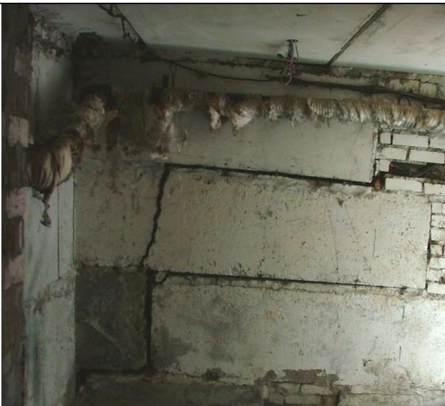
Сквозная наклонная трещина в средней части блока ФБС шириной раскрытия до 10 мм, переходящая в горизонтальную трещину по шву между блоками; выкрашивание заделки вертикальных швов между блоками на отдельных участках
