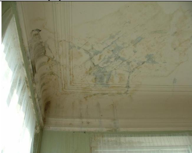
Многочисленные трещины различного характера шириной раскрытия до 2,0 мм по потолочному слою; отслаивание штукатурного слоя на отдельных участках; следы увлажнения и биоповреждения (грибок)
