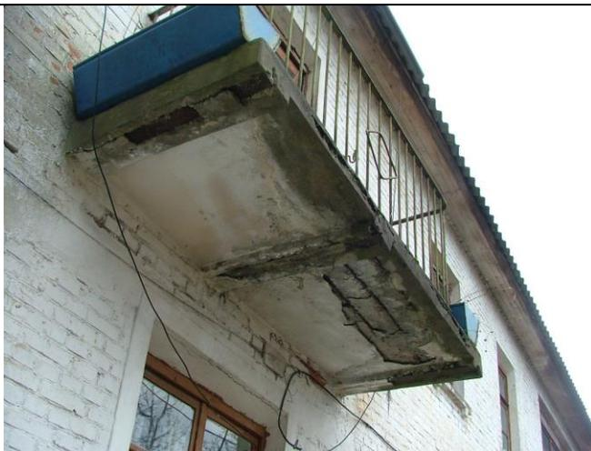
Отслаивание и разрушение защитного слоя бетона балок и плиты; оголение и коррозия стальных балок по нижней поверхности, арматуры плиты на отдельных участках; следы увлажнения и биоповреждения (мох, плесень) на многочисленных участках
