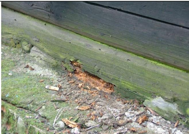
Разрушение древесины нижнего бревна дереворазрушающими грибами (гниль); многочисленные повреждения древесины древоточцами на отдельных участках; продольная трещина по боковой поверхности второго венца шириной раскрытия до 5,0 мм; отдельные выпадающие сучки; следы увлажнения и биоповреждения (мох)
