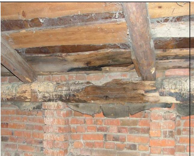
Разрушение дереворазрушающими грибами (гниль) древесины мауэрлата; продольная трещина по боковой поверхности мауэрлата шириной раскрытия
