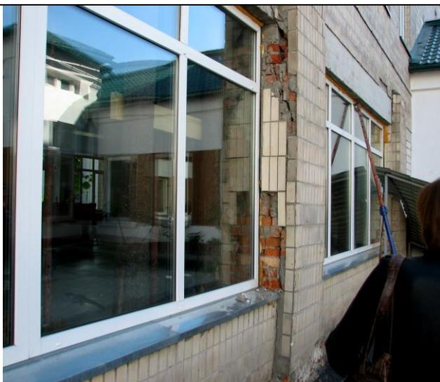
Выпучивание кладки на величину до 20 мм с образованием вертикальной трещины шириной раскрытия до 7,0 мм; отслаивание и обрушение участков облицовочного слоя
