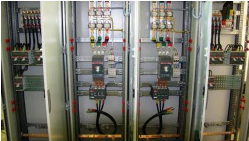
Рисунок 6.2 – Пример электрощитовой здания
