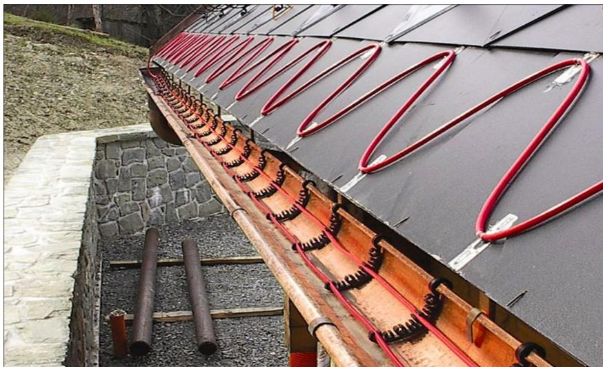
Рисунок 6.11 – Пример укладки кабеля на крыше и водостоке
