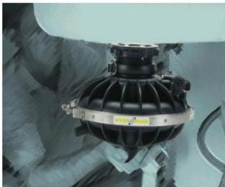
Рисунок 5.12 – Механический измельчитель мусора
