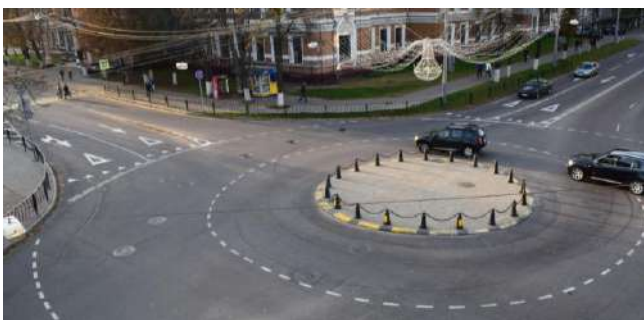
Рисунок 2 – Пересечение улиц Кирова и Красноармейской, г. Гомель
