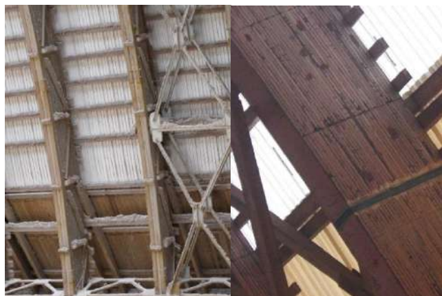
Рисунок 1 – Способы усиления деревянных арочных конструкций:
