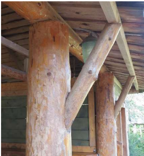
Рисунок 1 – Узел подкоса деревянной цельной стойки
