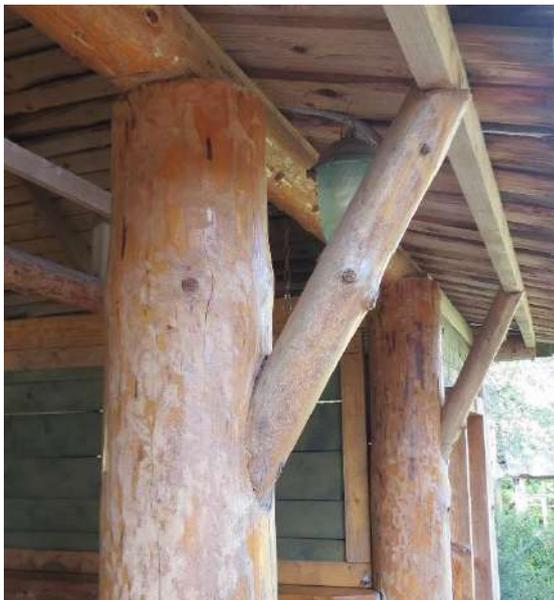
Рисунок 1 – Узел подкоса деревянной цельной стойки
