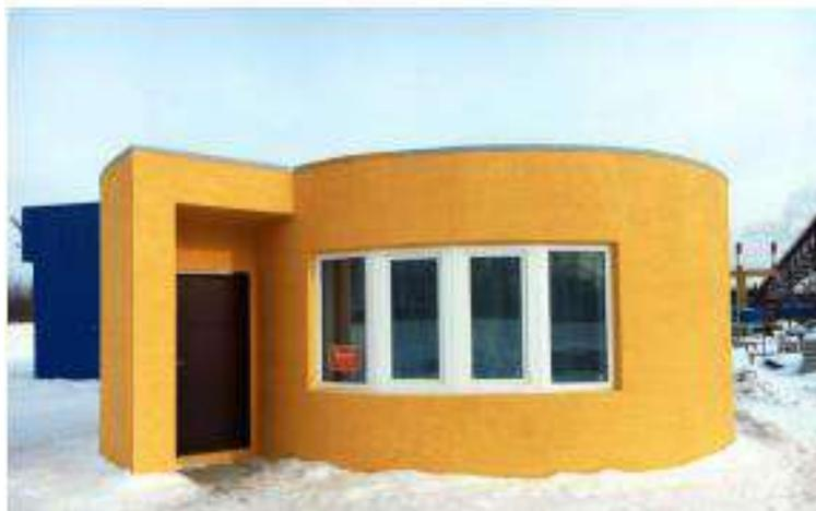
Рисунок 1 – Отпечатанный на 3D-принтере дом площадью 38 м<sup>2</sup>
