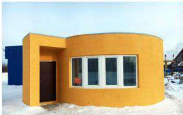
Рисунок 1 – Отпечатанный на 3D-принтере дом площадью 38 м 2
