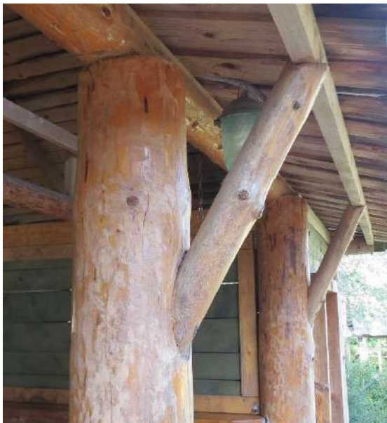
Рисунок 1 – Узел подкоса деревянной цельной стойки
