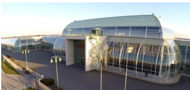
Рисунок 1 – Современный тепличный комплекс Anthura
