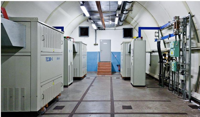
Рисунок Б.1 – Расположение шкафов выпрямительного агрегата тяговой подстанции
