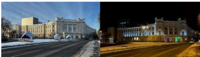
Рисунок 2 – Тюменская строительная академия. Свет на фасадах
