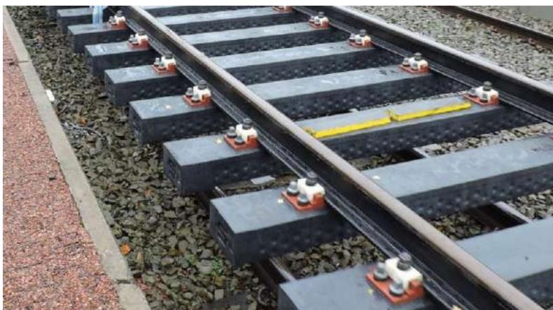
Рисунок 2 – Применение ПКМ для изготовления шпал
