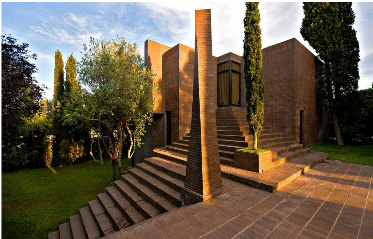
Рисунок 2.28 – Дом Бофилла (Vofill House), Монтрас, Барселона, 1973
