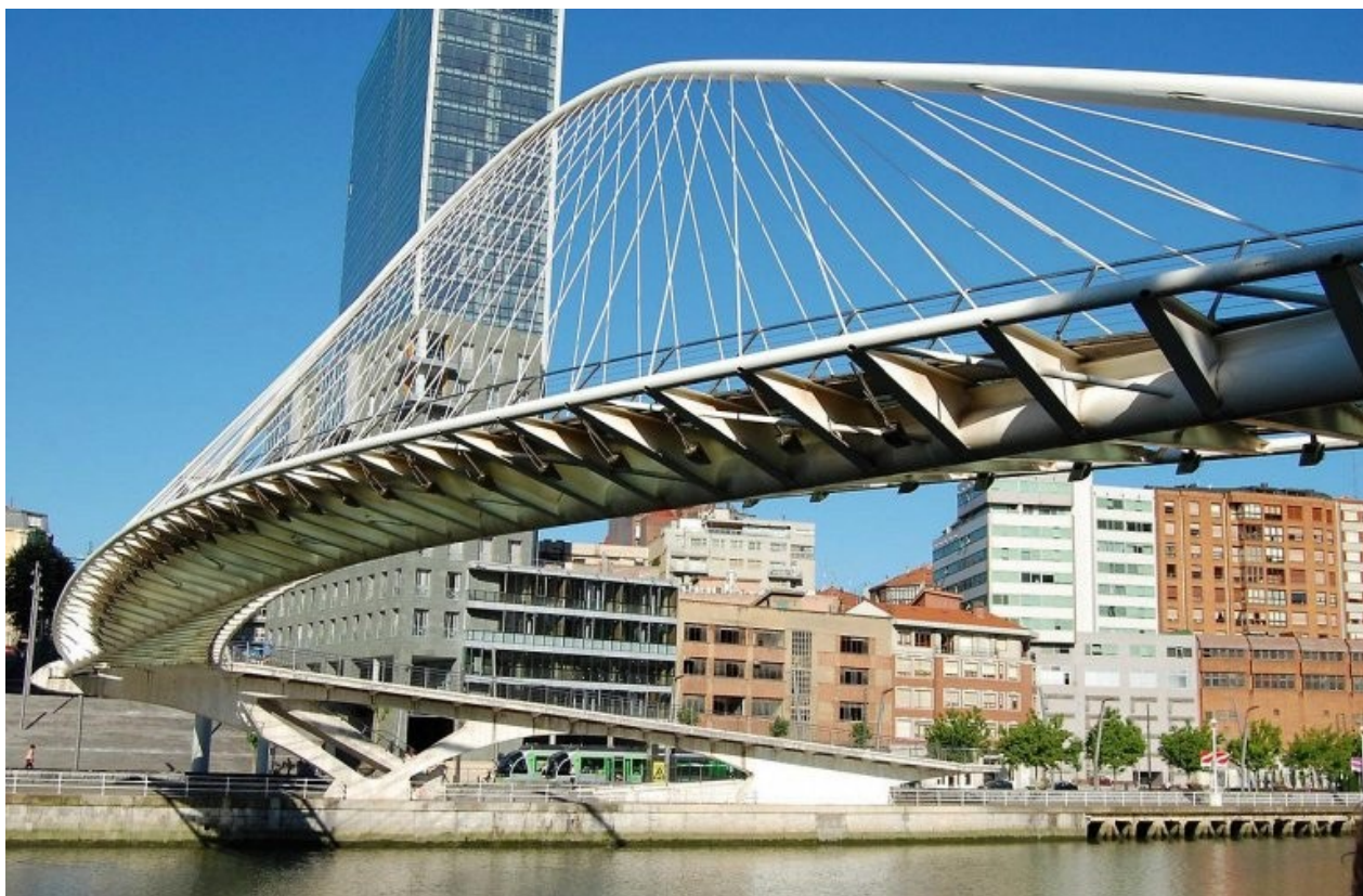
Рисунок 2.16 – Мост Субисури, Бильбао, Испания, 1997
