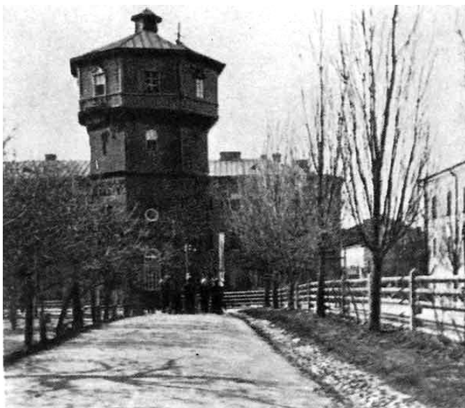
Первая водонапорная башня
