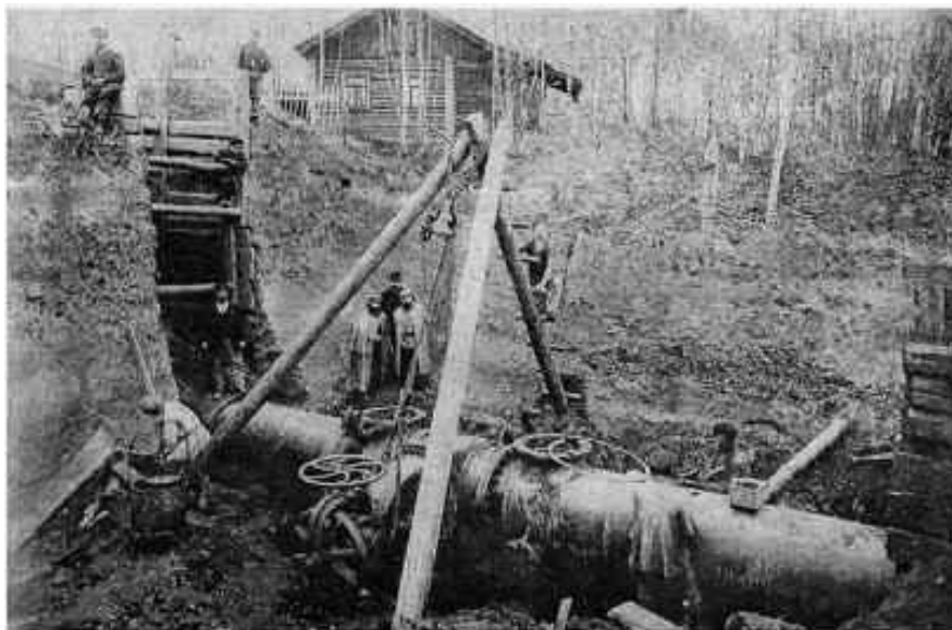
Прокладка водопроводной трубы
