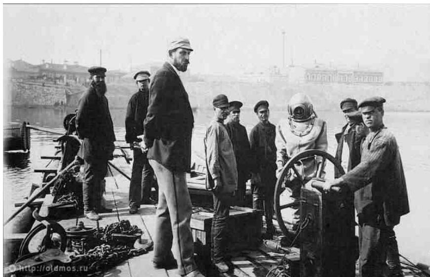
Прокладка водопроводного сифона у Краснохолмского моста. 1897 г.
