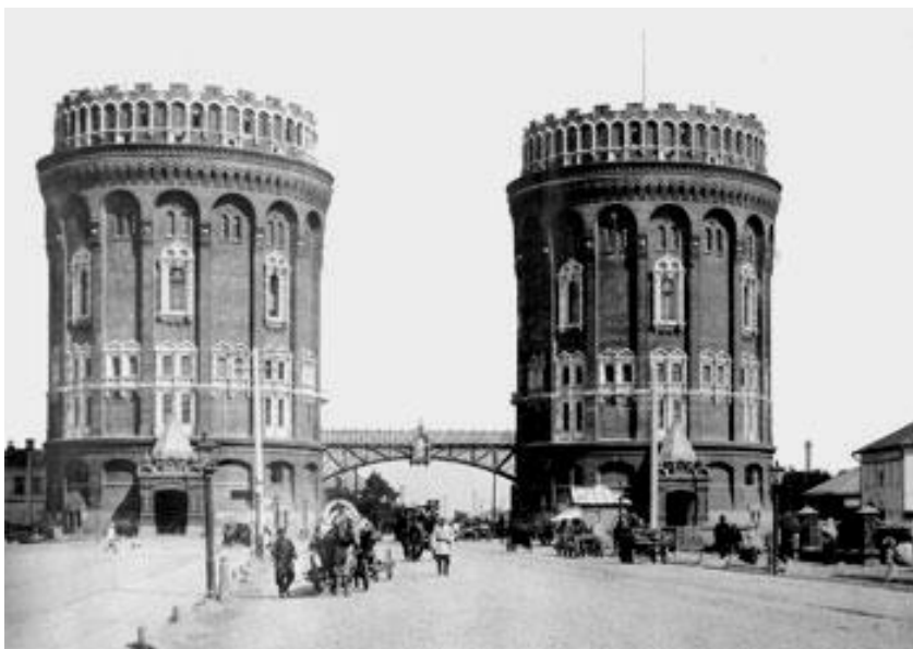
Крестовские водонапорные башни Мытищинского водопровода. В верхних ярусах находились резервуары, а на пяти нижних этажах – жилые и служебные помещения
