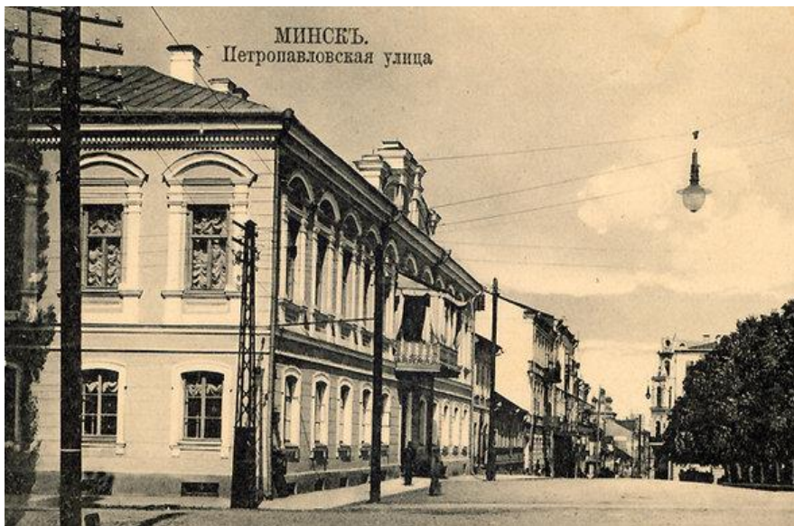
Одна из центральных улиц города – Петропавловская, оборудованная электроосвещением
