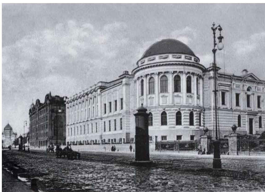
Электрический дуговой фонарь возле здания МГУ
