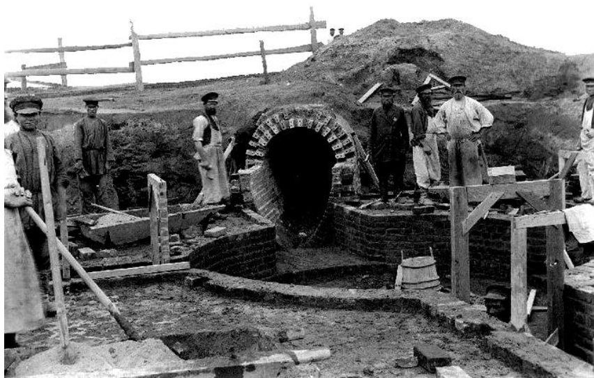
Строительство канализационного канала
