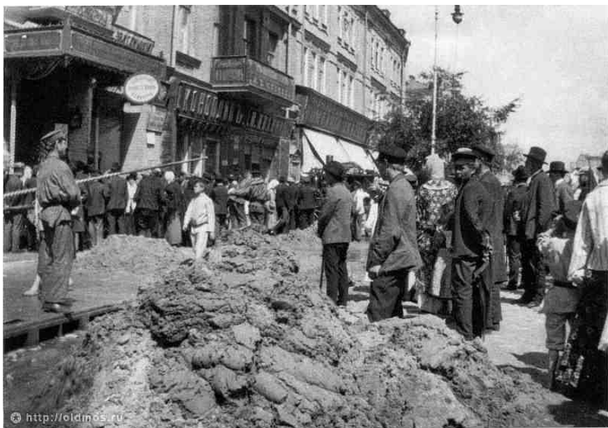
Прорыв водопровода на Кузнецком мосту. 1898 г.
