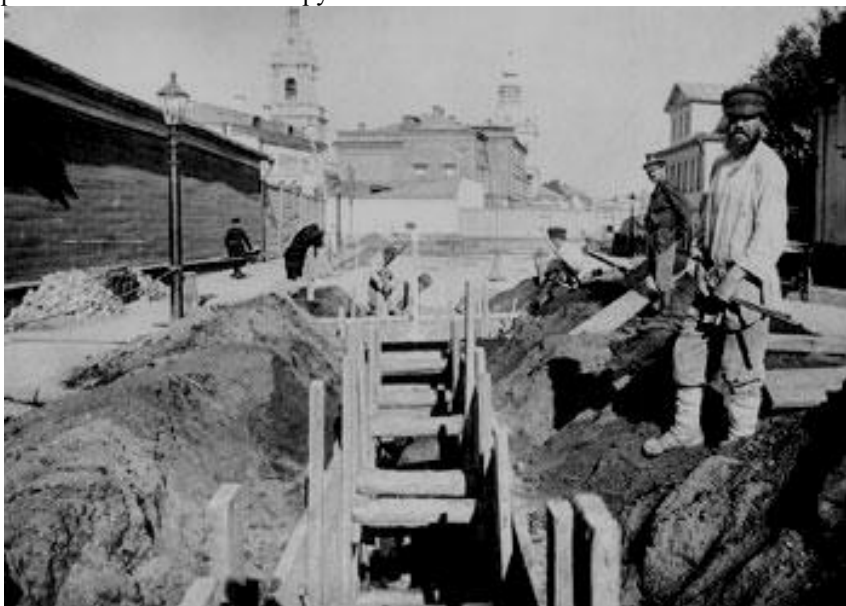
Устройство самотечной ассенизационной канавы. 1890-е годы
