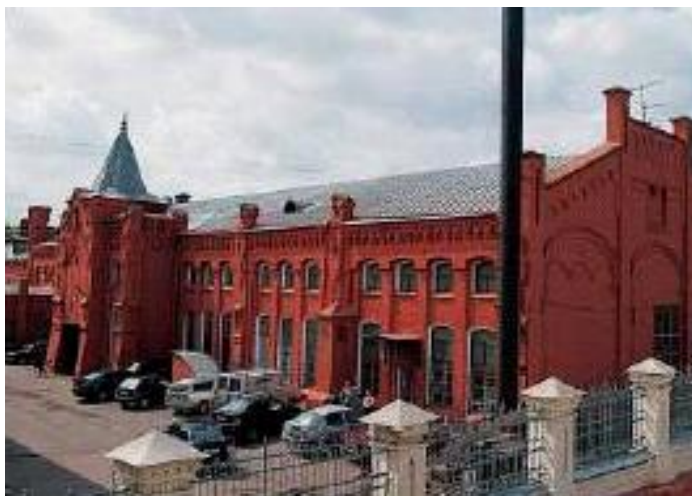
Главная канализационная насосная станция, архитектор Максим Гешпенер. 1898 г.
