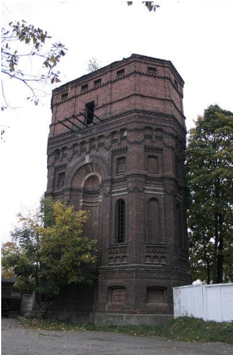
Водонапорная башня на ул. Авдодоровской
