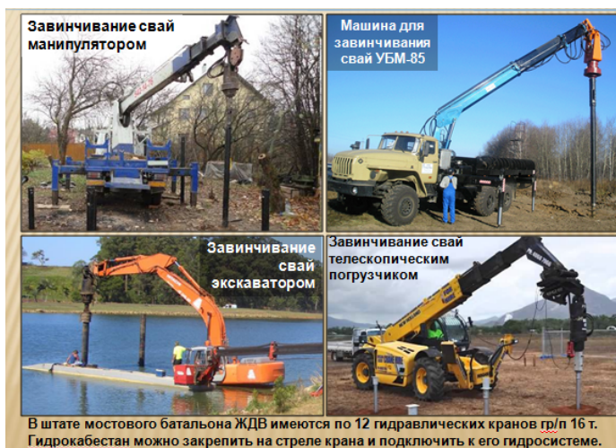
Рисунок 9 – Использование машин с гидроприводом для завинчивания свай
