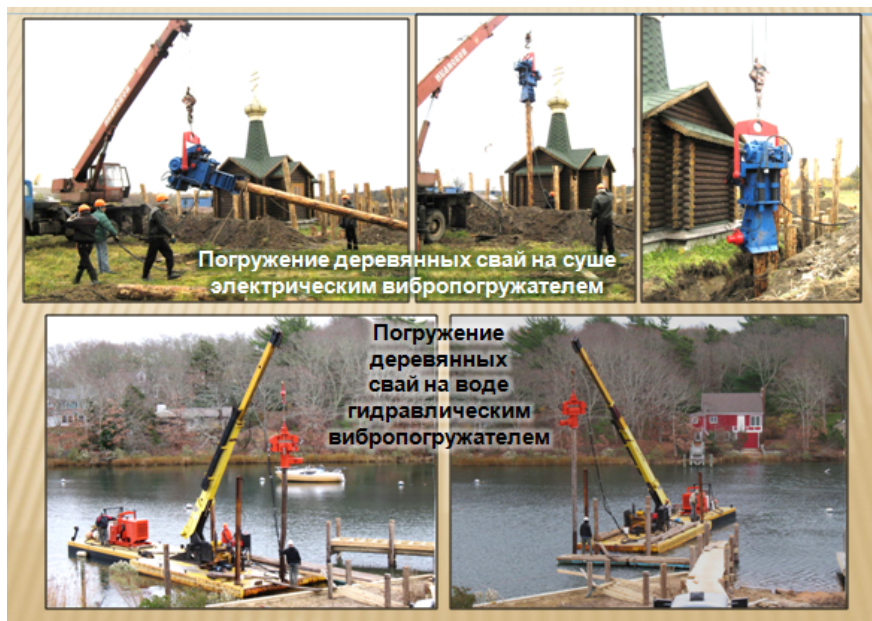
Рисунок 7 – Бескопровая забивка свай
