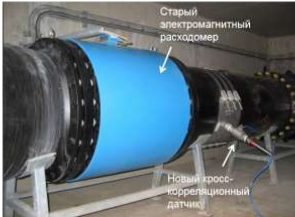
Рисунок 3.7 – Сравнение размеров и способа установки электромагнитного и кросс-корреляционного расходомеров
