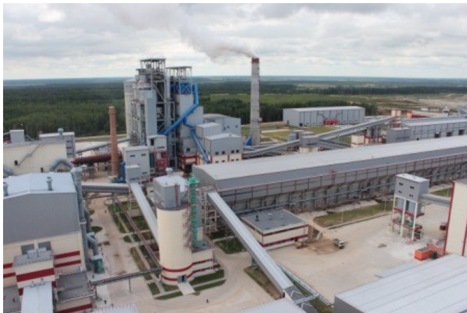
Рисунок 6.1 – Цементобетонный завод (г.Кричев)
