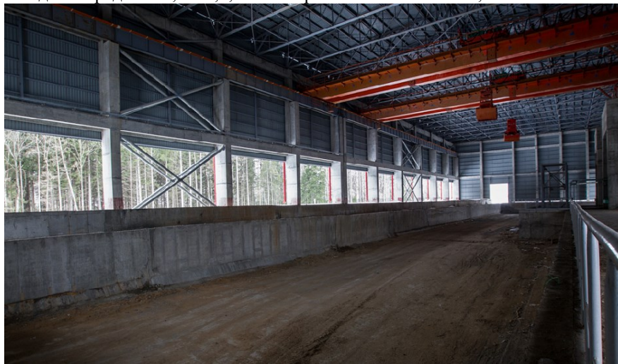
Рисунок 6.10 – Амбарный склад цемента
