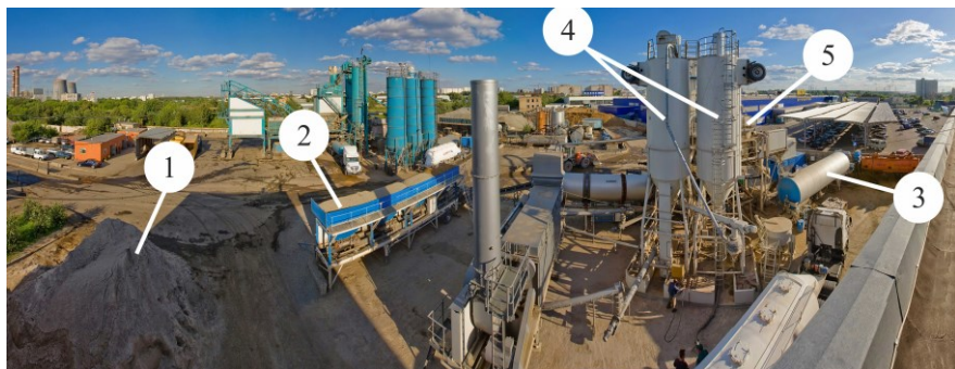
Рисунок 5.2 –Генеральный план притрассового АБЗ: 1 — склад каменных материалов; 2 —агрегат питания; 3 — битумная цистерна; 4 — бункеры минерального порошка; 5 — смеситель; 6 — бункеры готового материала; 7 — кабина управления; 8 — ёмкости с водой; 9 — отделение приготовления добавок; 10 — контора с лабораторией; 11 — материально-технический склад; 12 — противопожарные резервуары; 13 — ремонтные мастерские; 14 — площадка для открытых ремонтных работ; 15 — бытовые помещения; 16 — электростанция; 17 —артезианская скважина; 18 — передвижная компрессорная установка; 19 — отделение лабораторий; 20 — очистные сооружения; 21 — склад ГСМ; 22 - весовая с автоматическими весами грузоподъемностью 30 т; 23 - канализационные очистные сооружения; 24 - склад ГСМ
