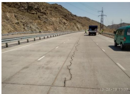
Рисунок 1 – Результаты негативного воздействия движения грузовых АТС с перегрузом на автомобильных дорогах Республики Узбекистан
