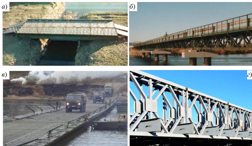
Рисунок 2 – Временные автодорожные мосты:
