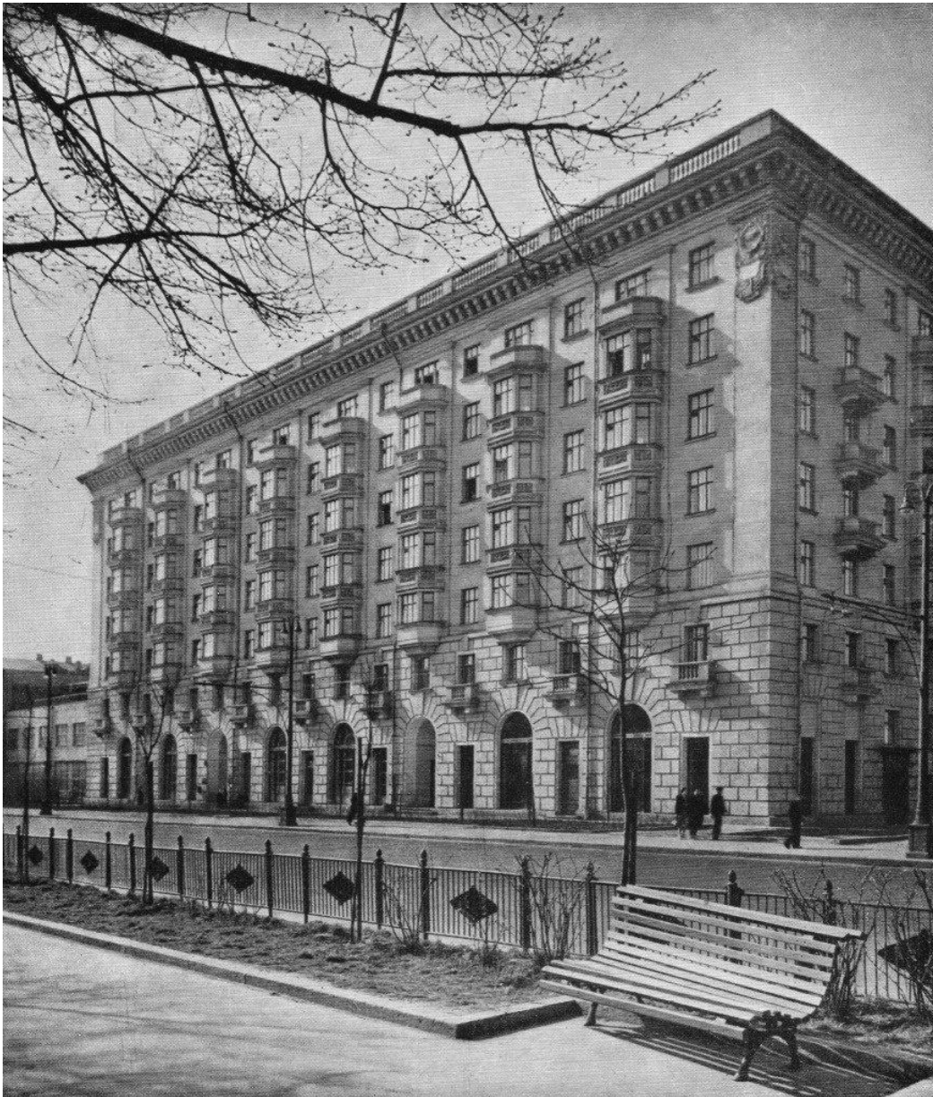
Рисунок 1.4 – Жилой дом № 9 на Ленинградском проспекте г. Москва. А. Г. Рочегов 1950 г.
