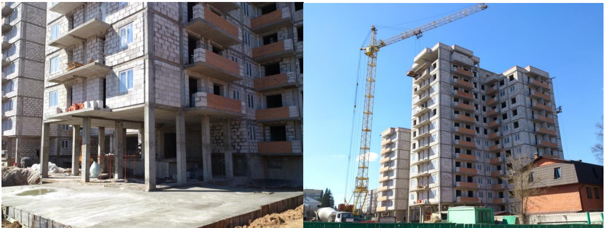
Рисунок 9.8 – На строительстве 8-10-12 этажного жилого дома по ул.Волотовской в г.Гомеле
