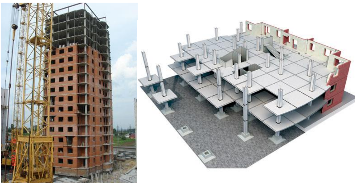
Рисунок 9.1 – Технология возведения системы КУБ-2,5
