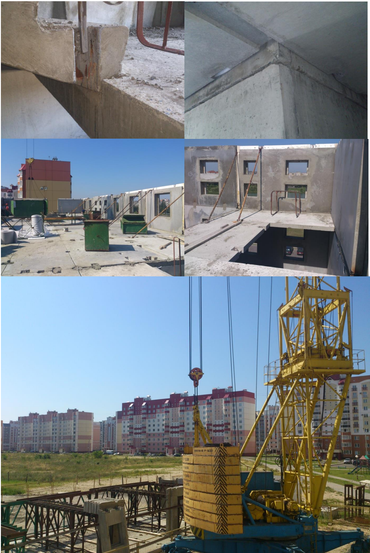
Рисунок 9.13 – Конструктивные особенности серии П-152м
