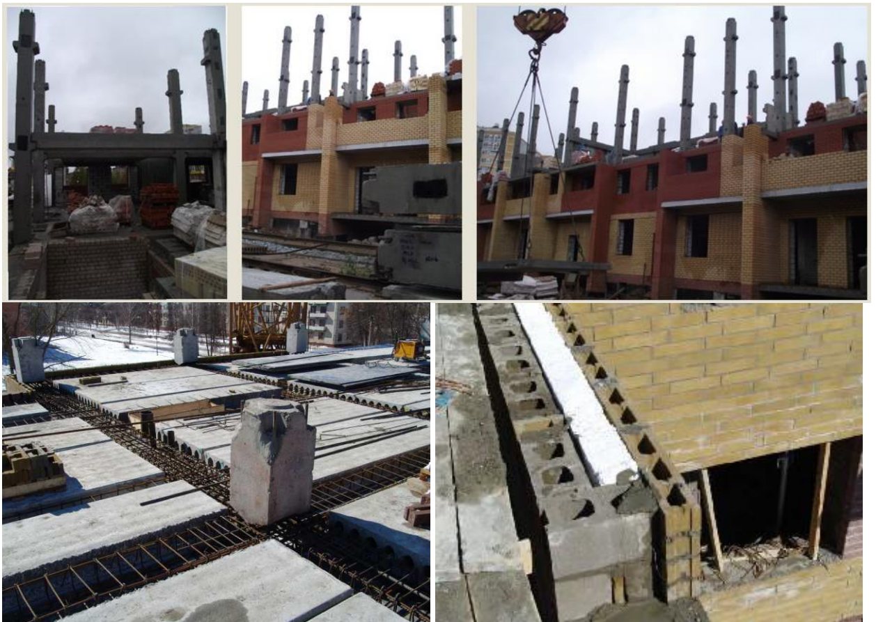
Рисунок 9.5 – Технология возведения домов серии Б 1.020.1
