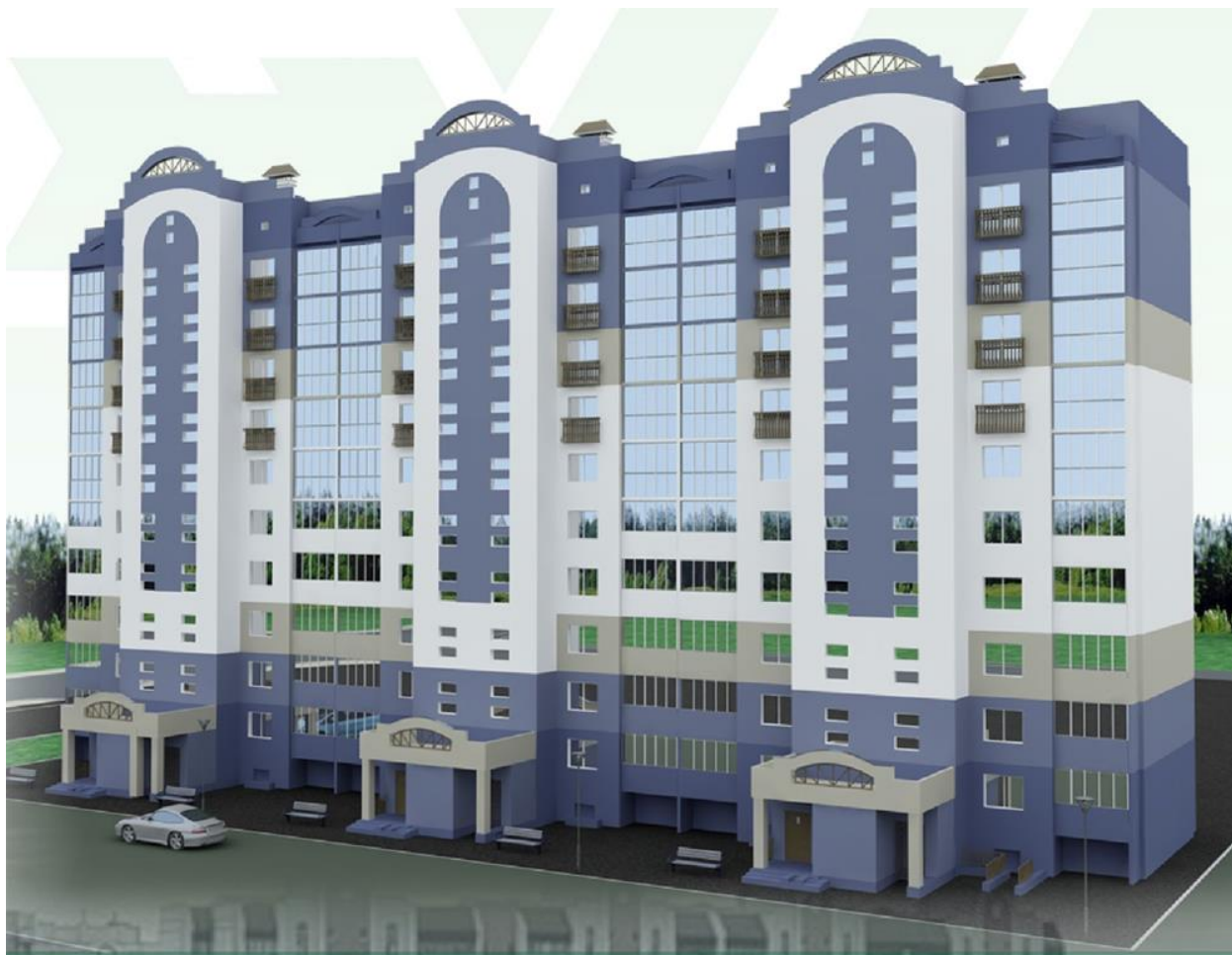
Рисунок 9.10 – 10-этажный 5-секционный жилой КПД № 20 в микрорайоне № 104 г.Гомеля запроектирован с использованием индустриальных изделий типового проекта 152М-1.10. Жилой дом состоит из пяти секций, 10 этажей, 200 квартир.
