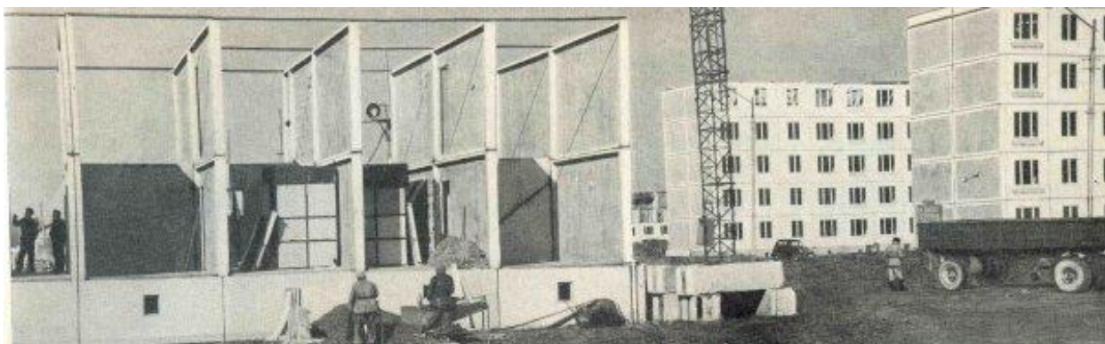
Рисунок 1.5 – Строительство дома серии К-7
