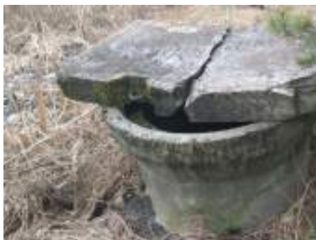
Рисунок 5 – Камера выпуска на поля фильтрации
