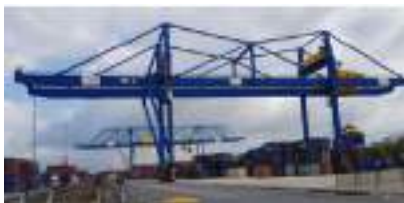
Рисунок 3 – Контейнерный перегружатель на рельсовом ходу
