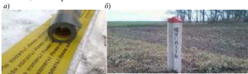
Рисунок 2 – Средства предупреждения механического повреждения кабельной трассы:
