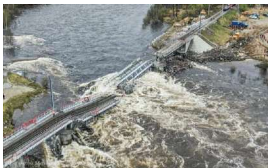
Рисунок 1 – Обрушение больших железнодорожных мостов вследствие подмыва русловых опор: а – через реку Абакан в Республике Хакасия (май 2011 г.); б – через реку Кола в Кольском районе Российской Федерации (июнь 2020 г.)
