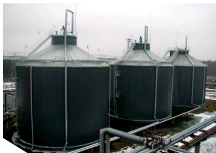
Рисунок 3.6 – Конструкции метантенков: а – яйцевидная форма; б – цилиндрическая форма
