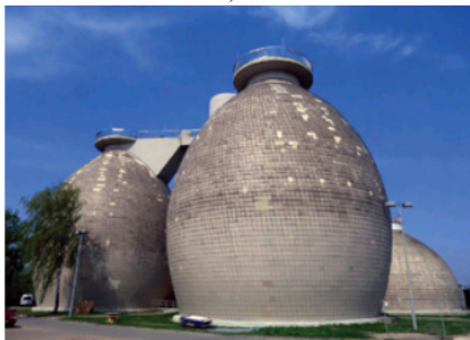
Рисунок 3.6 – Конструкции метантенков: а – яйцевидная форма; б – цилиндрическая форма
