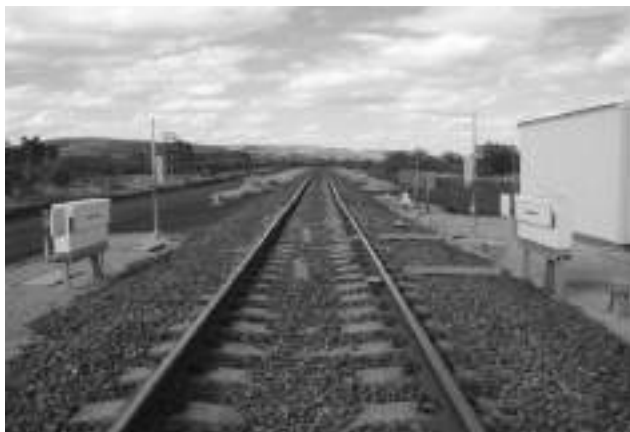
Рисунок 6 – Оборудование комплекса RailBAM
