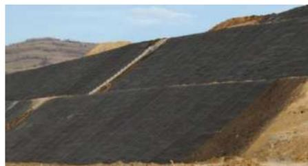
Рисунок 2 – Укрепление откосов высокой насыпи геоматами
