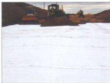
Рисунок 1 – Укладка геосинтетических материалов в слоях дорожной одежды
