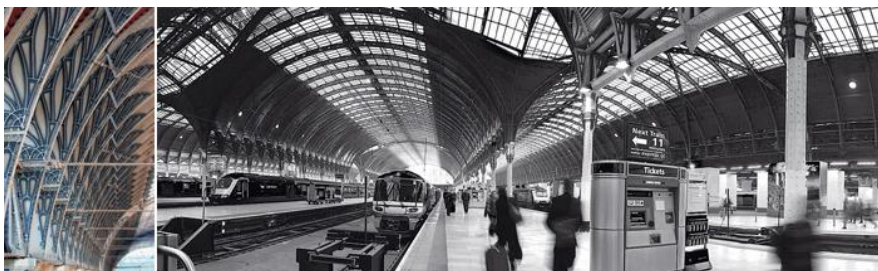
Рисунок 1.12 – Ажурные металлические конструкции сводов над платформами вокзала Паддингтон в Лондоне
