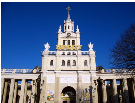
Рисунок 1.5 – Здание вокзала станции Брест-Центральный
