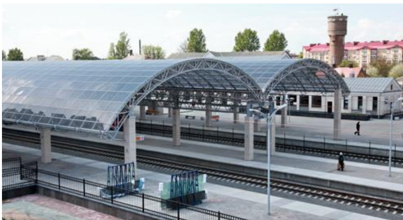
Рисунок 2.3 – Новый навес арочного типа на платформах вокзала Брест
