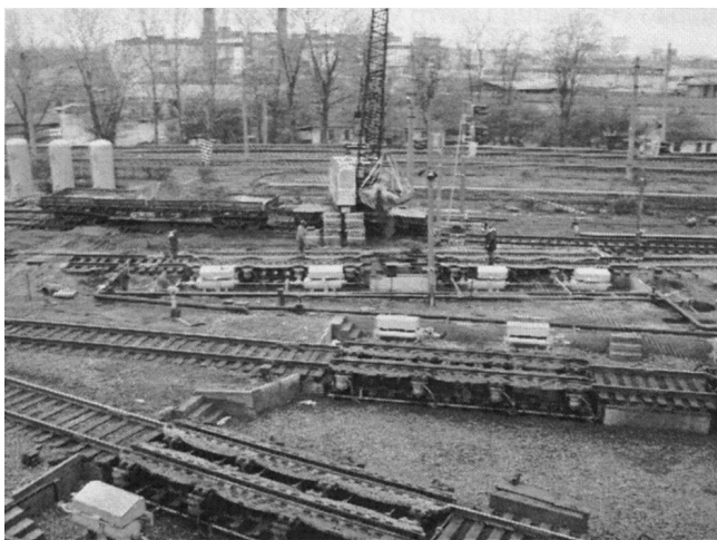
Рисунок 4 – Фотография реконструкции станции Минск-Сортировочный
