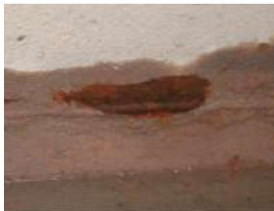
Рисунок 2 – Язвенная коррозия стальных водопроводных труб
