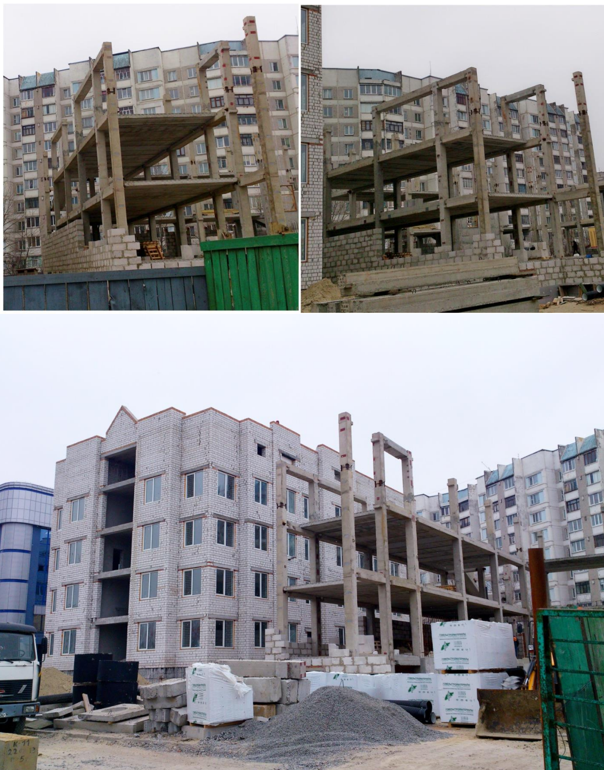
Рисунок 4.6 – Строительство каркасно-панельного здания в г. Гомеле
