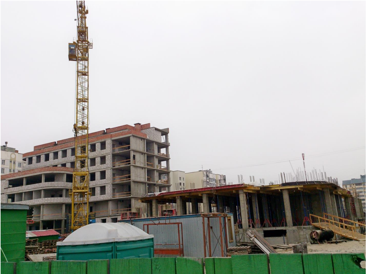
Рисунок 5.1 – Строительство монолитного общественного здания в г. Гомеле
