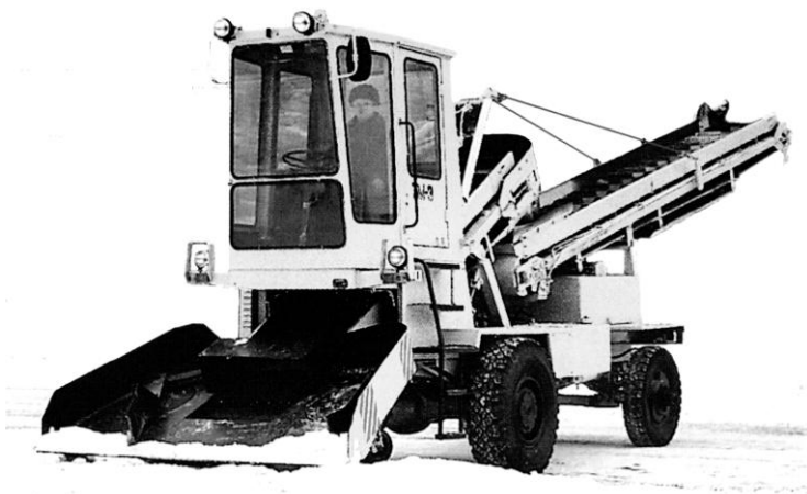
Рисунок 3.20 – Снегопогрузчик Амкодор 37 (ТМ-3-01) с лаповым питателем
