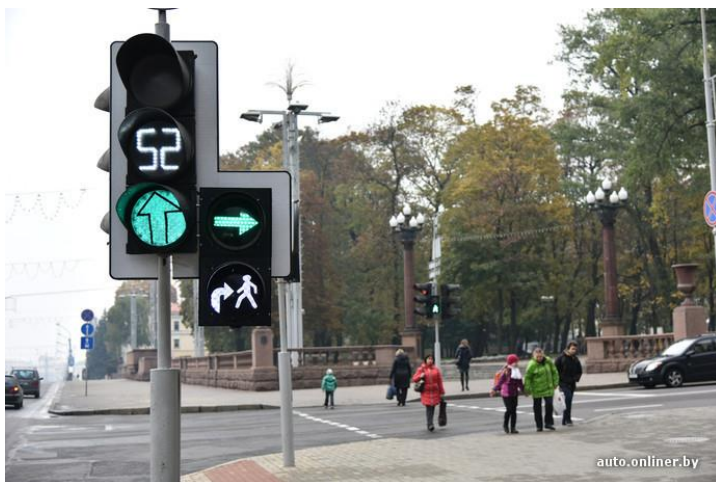
Рисунок 3.73 – Пример применения со светофорами дополнительного оборудования в местах конфликтного движения правоповоротного транспортного потока и пешеходов
