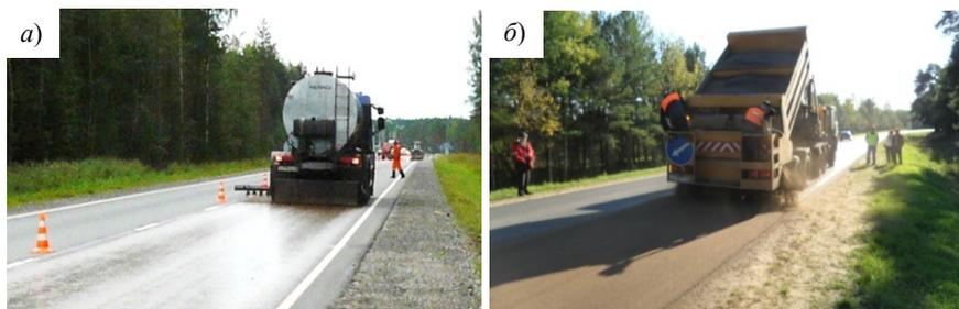
Рисунок 2.6 – Технология пропитки асфальтобетонных покрытий
