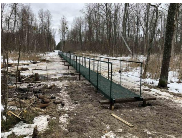
Рисунок 5 – Установка перильного ограждения
