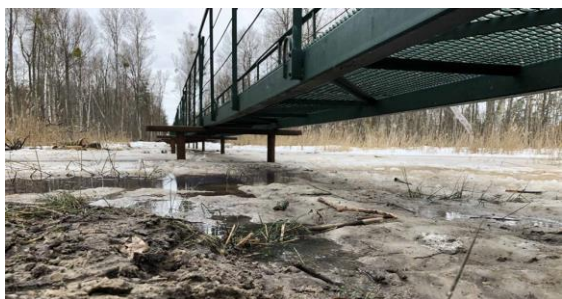
Рисунок 7 – Эксплуатация моста на структурно-неустойчивых грунтах с применением малогабаритного сборно-разборного мостового пролета
