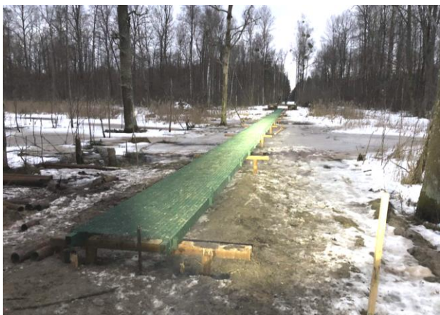
Рисунок 4 – Установка главных балок и пешеходного настила
