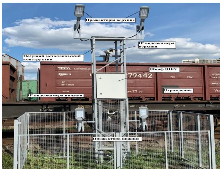
Рисунок 2 – Элементы напольного комплекса «СТЗ.ИНВ»
