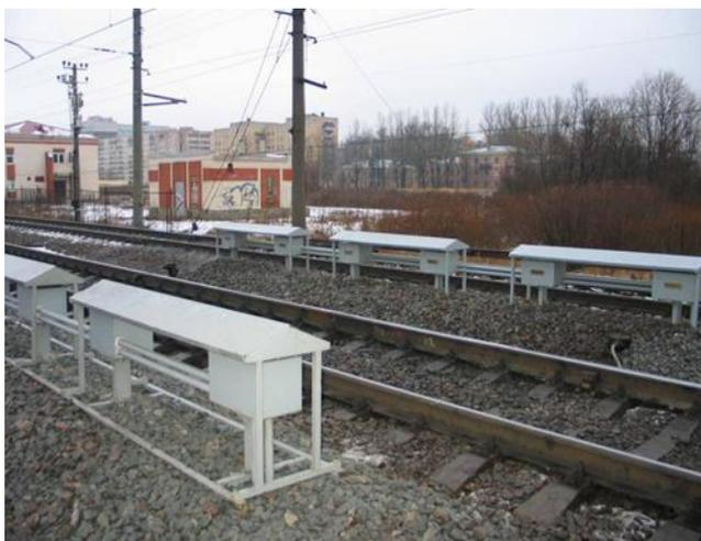
Рисунок 1.22 – Пост акустического контроля выявления дефектов на ходу поезда
