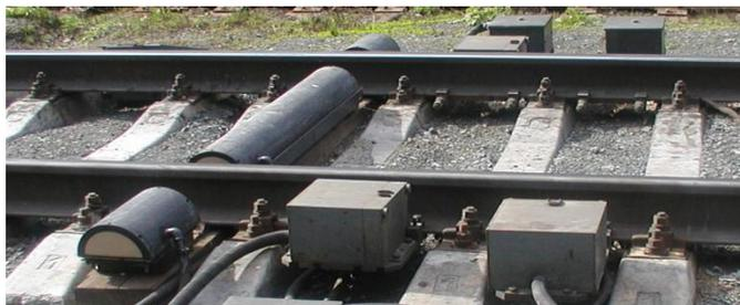
Рисунок 6.23 – Напольные устройства СКНГ и напольные камеры КНМ-05
